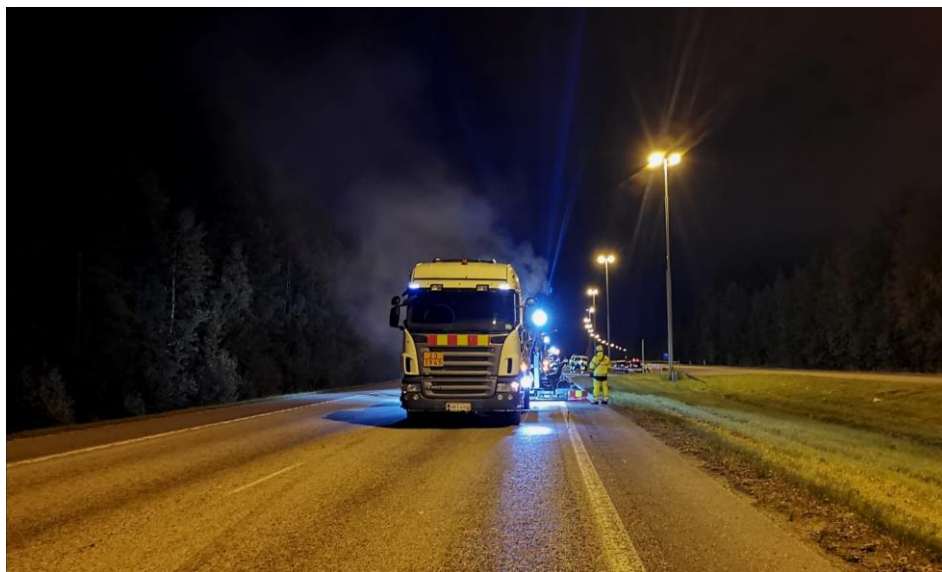
Kuva 21. Kuva Valtatie 4 työmaalta.
