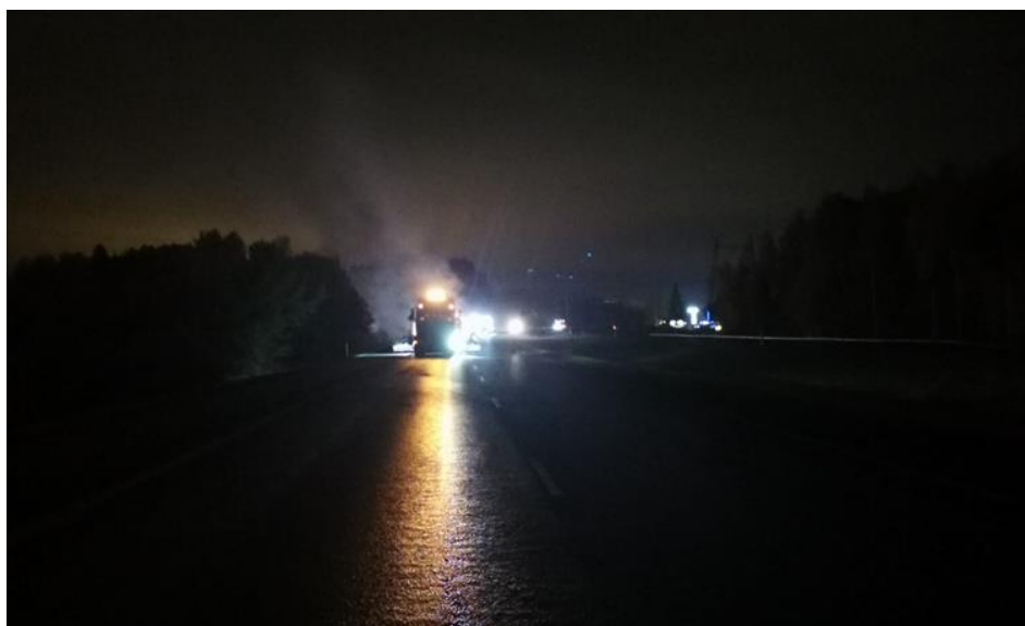
Kuva 22. Näkyvyys Valtatie 4 työmaalla yöaikaan, kun valot ovat sammuneet.
