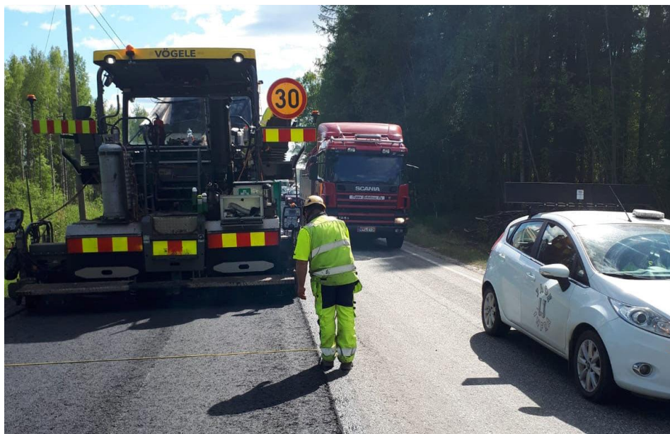
Kuva 11. Yksiajorataisen tien päällystystyömaa, jossa käytössä myös saattoauto. (Kuva: NCC)
