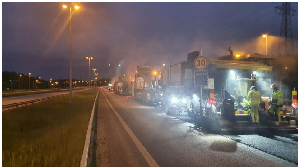
Kuva 10. Kaksiajorataisen tien päällystystyömaa. (Kuva: NCC)
