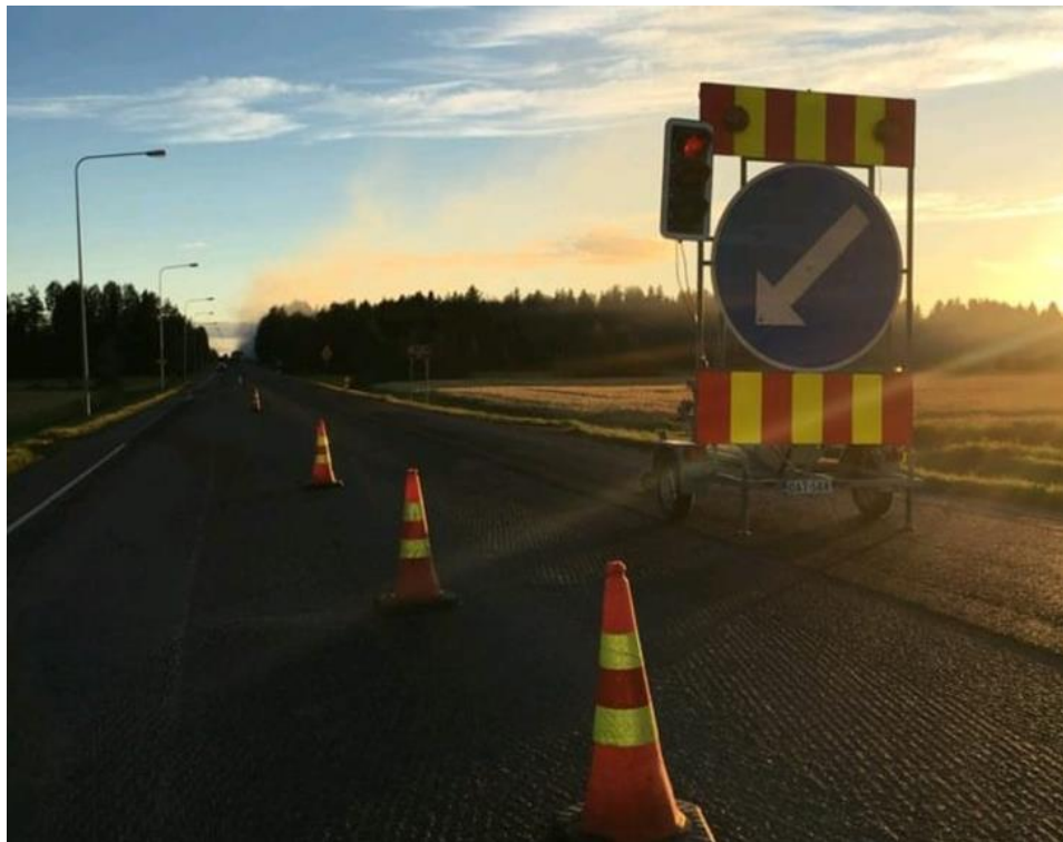
Kuva 3. Työmaa järjestelyt päällystystyömaalla. (Kuva: Sonja Hyvönen)
