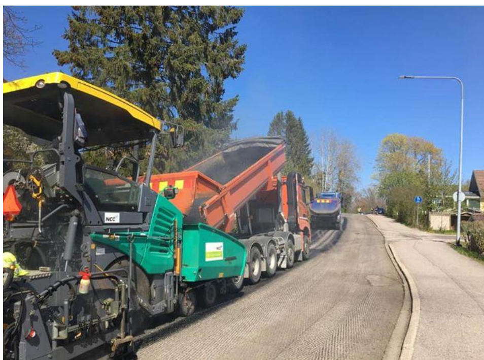
Kuva 12. Yksiajorataisen tien päällystystyömaa. (Kuva: NCC)
