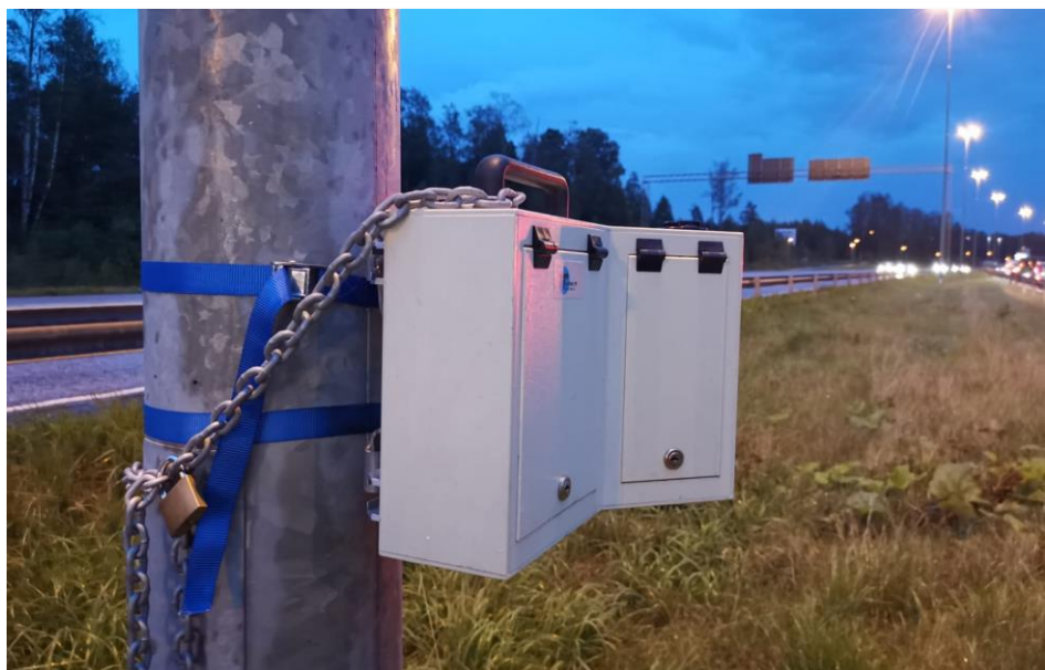
Kuva 8. Viacount laskin valtatie 4 työmaalla.
