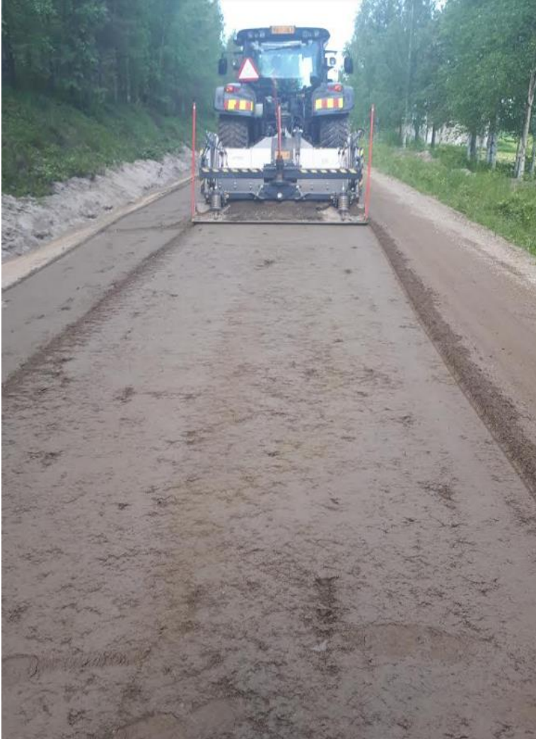
KUVA 5. Tien keskikohdan tiivistys ja lanaus (3)
