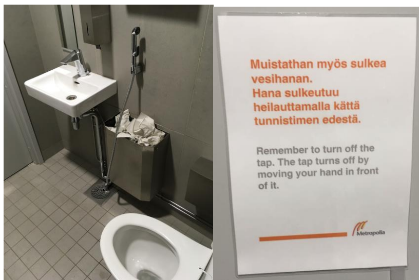
Kuva 17. Kosketusvapaa Oras Cubista -hana bideellä sekä hanaa koskeva opastusteksti samassa tilassa. Hanan etäisyys WC-istuimesta on 1 000 mm. Ulottuminen hanan ohjaukseksi vaatii huomattavaa kurottautumista käyttäjältä. [38]
