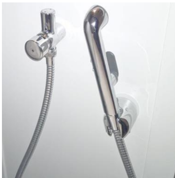
Kuva 6. Bideesuihku ja ajastettu painonapillinen sulkuventtiili. Bideekahva on sulullinen, vaikka niin ei tulisi olla. [23]
