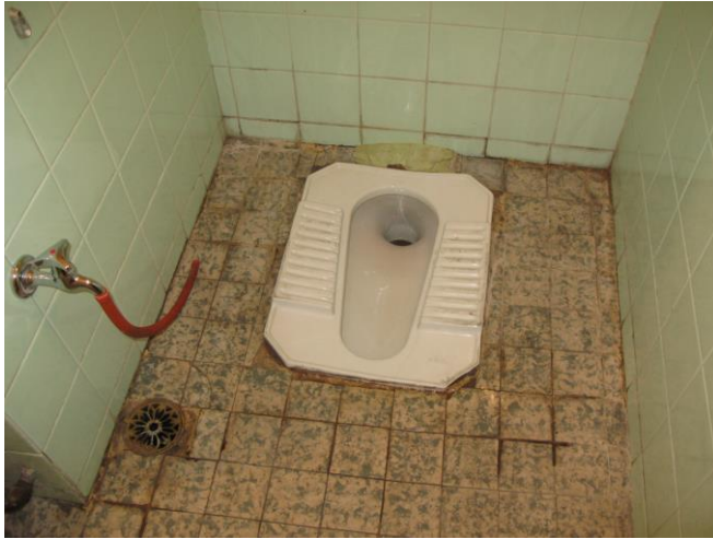
Kuva 1. Vesipostilla varustettu istuimeton vessa Syyriassa. Monesti vessassa on vesiaastia tai kannu pesun helpottamiseksi [19].
