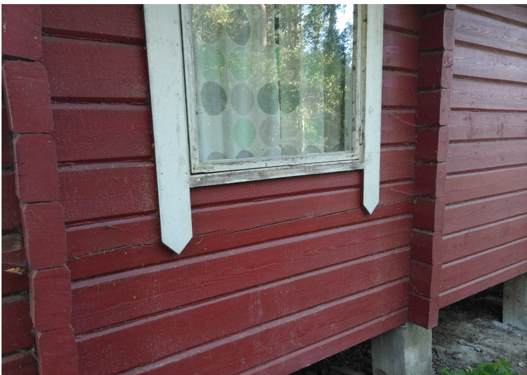
Kuva 3. Saman mökin auringon valolta ja tuulelta suojassa ollut seinä
