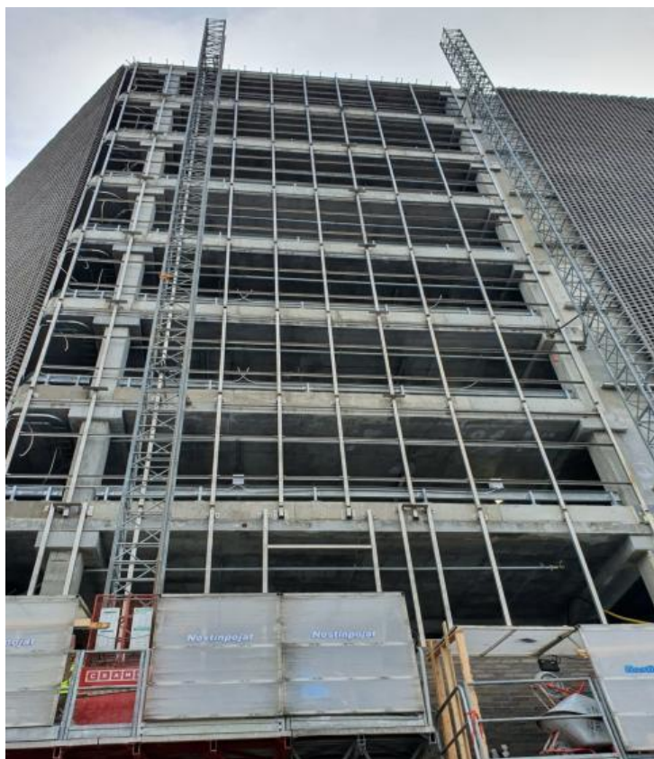
Kuva 5.1. Pitsitiiliseinän terästukirunko
