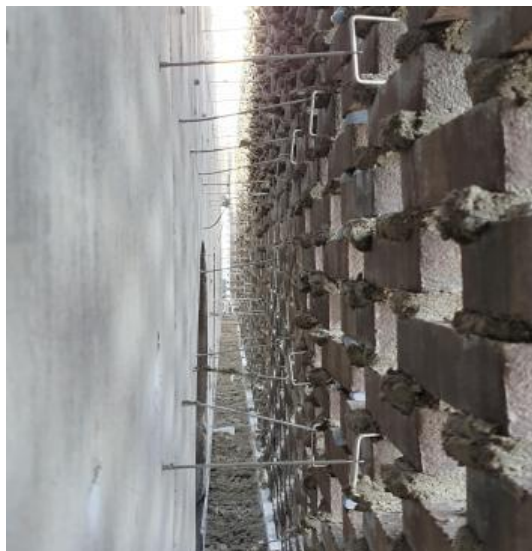
Kuva 4.18. Muuraussiteiden ja tiilisankojen suoruus
