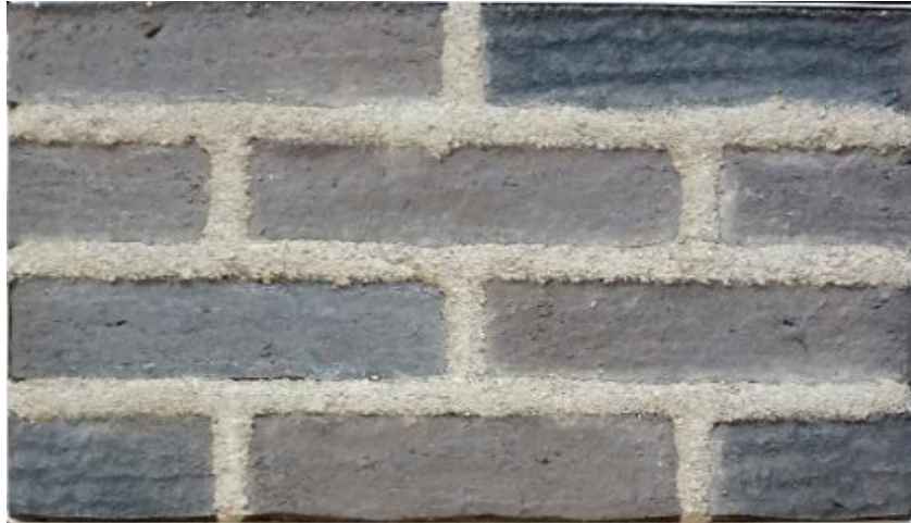
Kuva 4.1. Umpeen muurattu tiiliseinä (malli)
