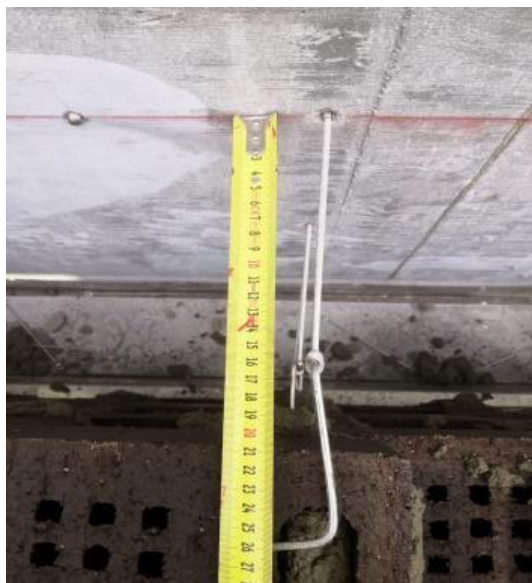
Kuva 4.17. Muuraussiteiden kiinnitys seinään
