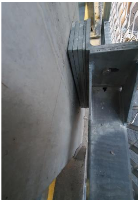
Kuva 5.2. Välikappaleet teräsrunгон ja betoniseinän välissä
