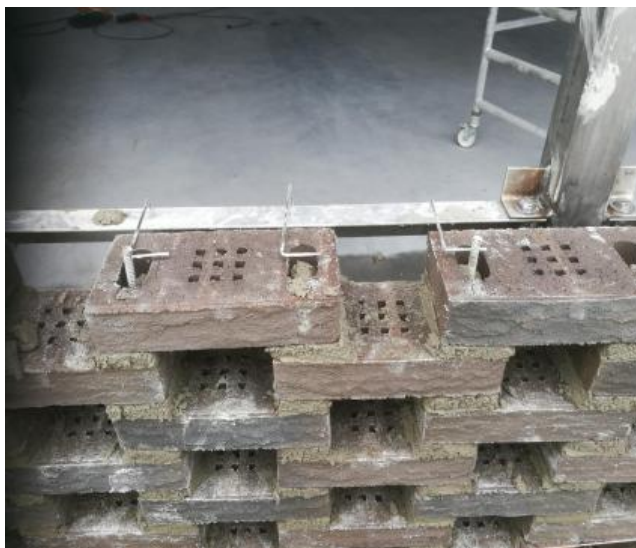
Kuva 4.16. Muurauksen raudoitus
