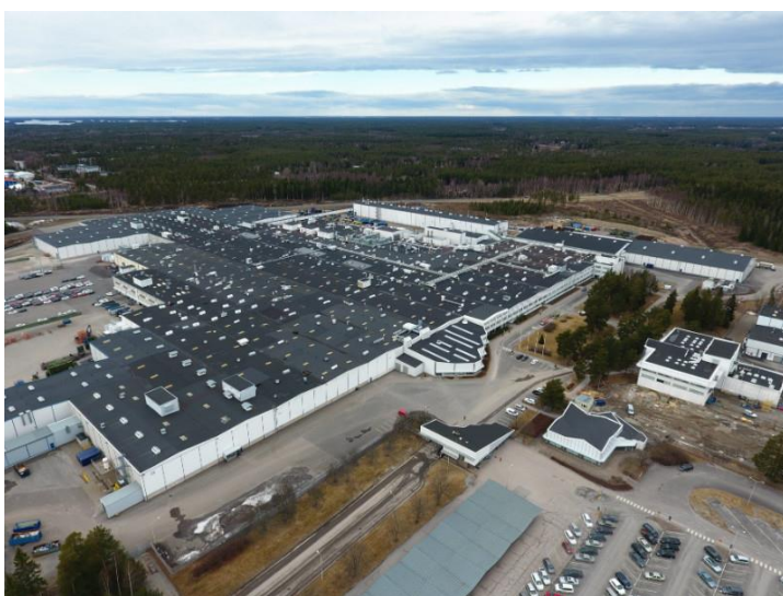
Picture 1 Valmet Automotive car manufacturing plant in Uusikaupunki.
