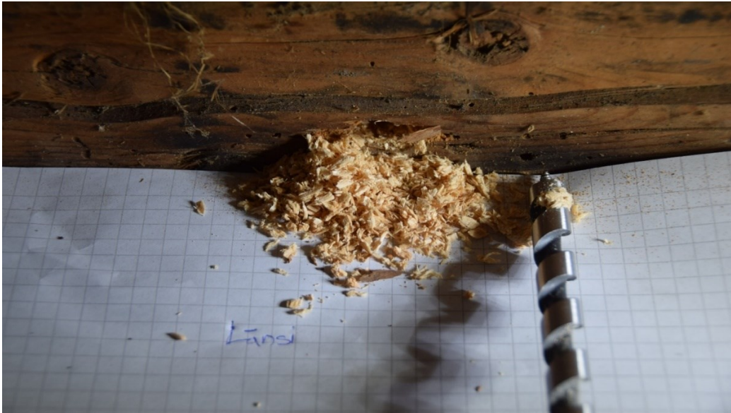
KUVA 12. Valokuva rakennuksen rungon kuntotutkimusporauksesta.
