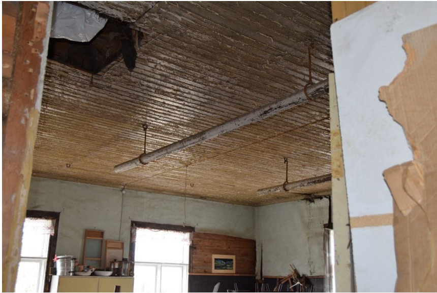
KUVA 23. Valokuva rakennuksen sisältä.
