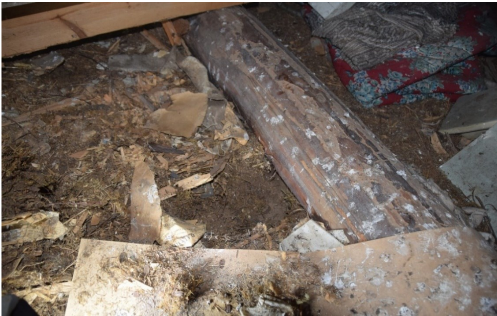
KUVA 14. Valokuva rakennuksen välipohjarakenteesta
