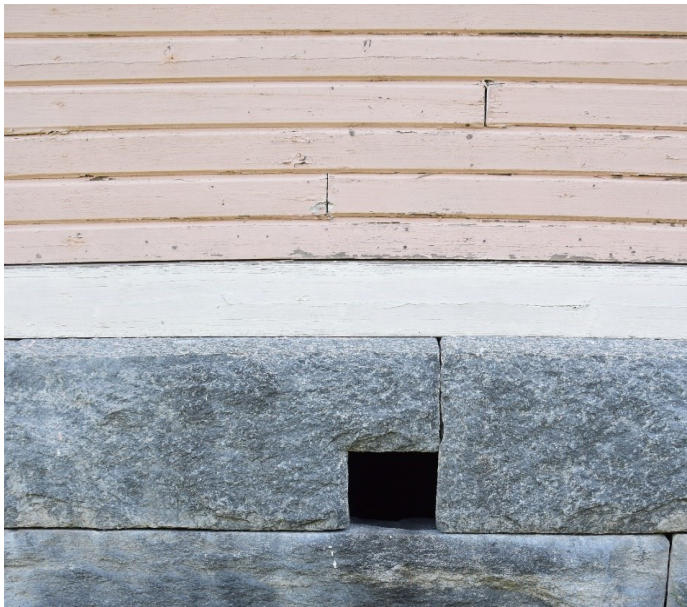
KUVA 10. Valokuva alapohjan tuuletusaukoista
