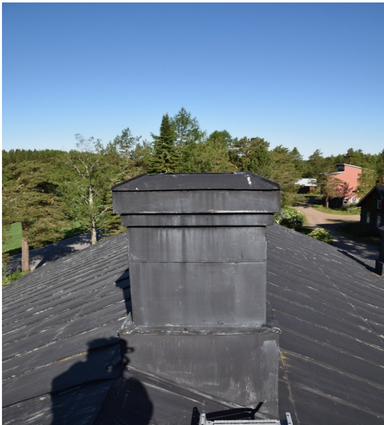
KUVA 19. Valokuva rakennuksen piipunpellityksestä.
