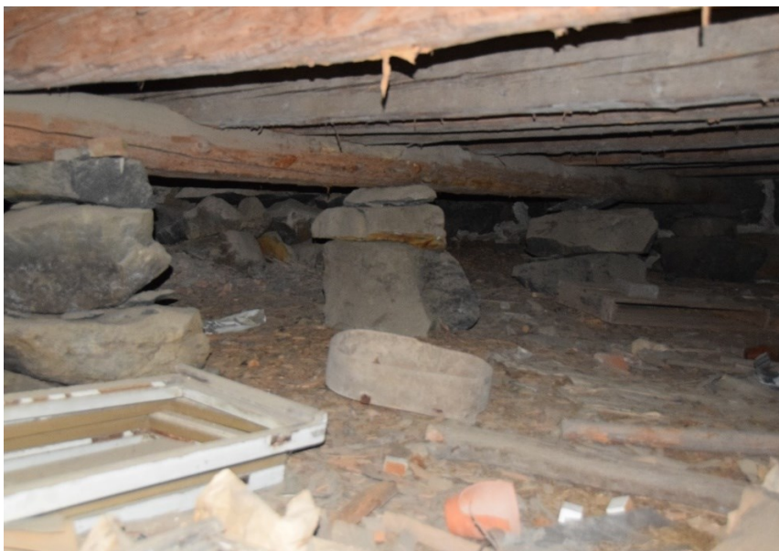
KUVA 9. Valokuva ryömintätilan alapohjarakenteesta
