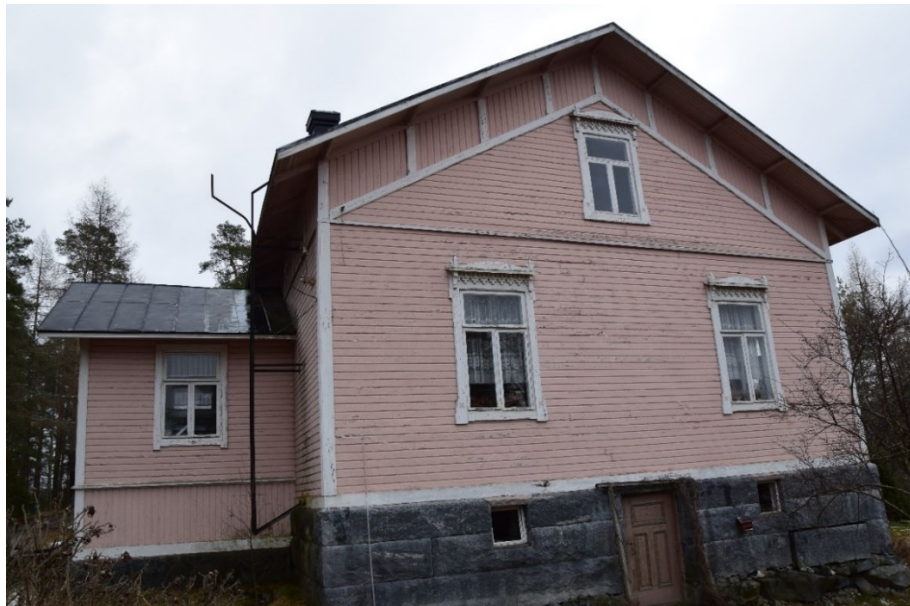
KUVA 22. Valokuva rakennuksen läntisestä julkisivusta.
