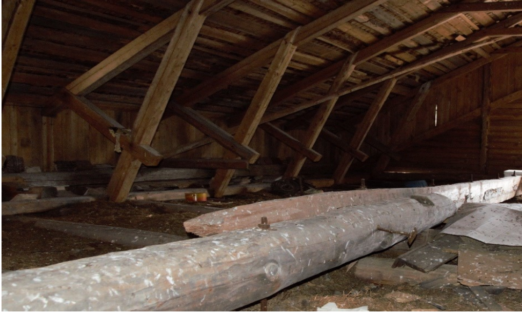
KUVA 15. Valokuva rakennuksen välipohjatukikannattimesta
