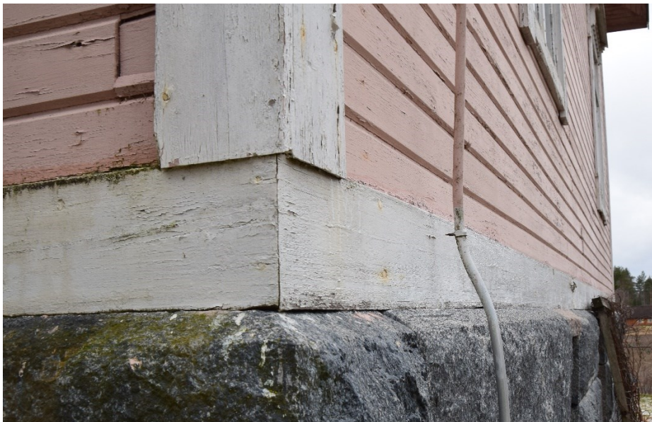
KUVA 24. Valokuva rakennuksen sokkelin ja julkisivun liitoskohdasta.
