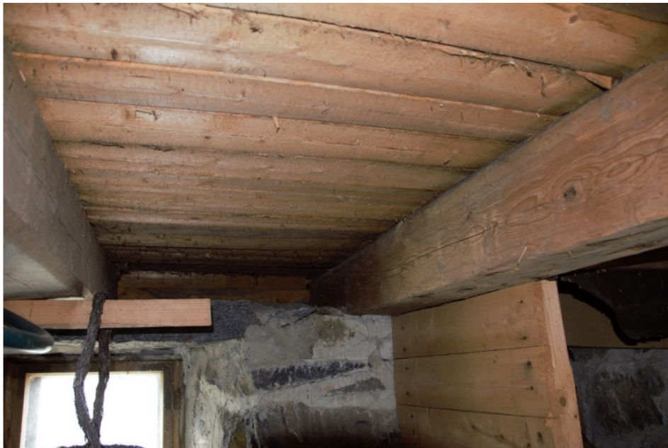
KUVA 8. Valokuva kellarin alapohjarakenteesta
