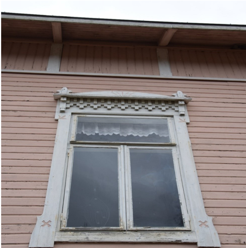
KUVA 20. Valokuva ulkopuolelta rakennuksen ikkunasta.
