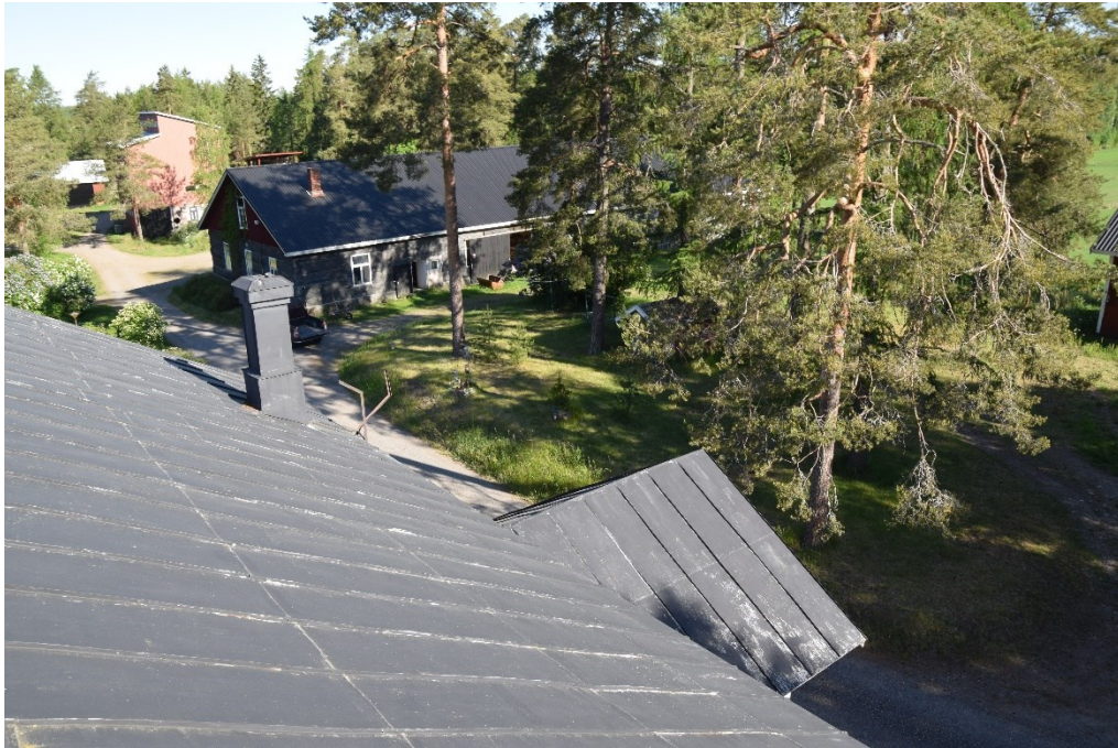
KUVA 18. Valokuva rakennuksen peltikatteesta.
