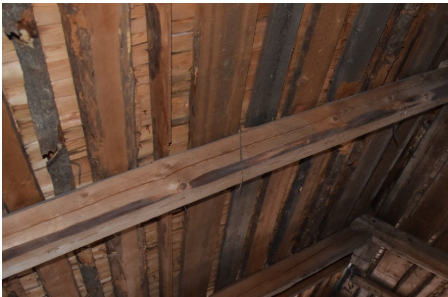
KUVA 16. Valokuva rakennuksen yläpohjarakenteesta
