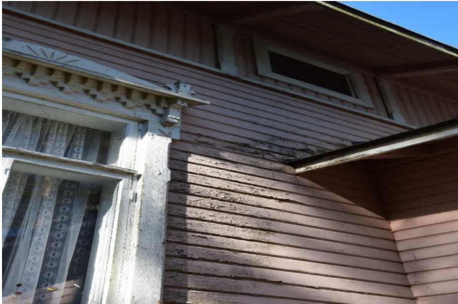
KUVA 23. Valokuva rakennuksen pohjoisjulkisivusta.
