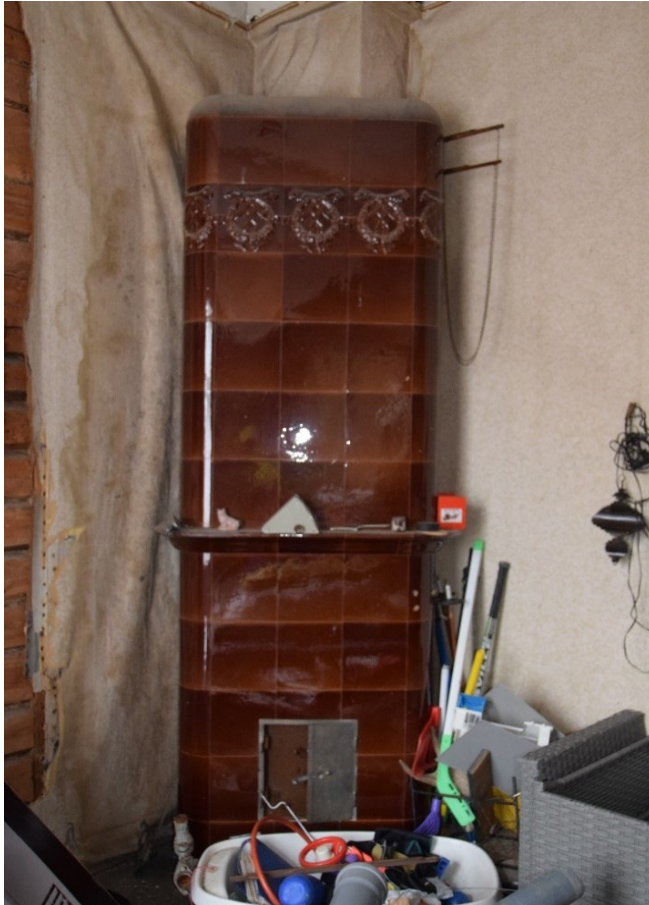
KUVA 25. Valokuva rakennuksen sisältä.
