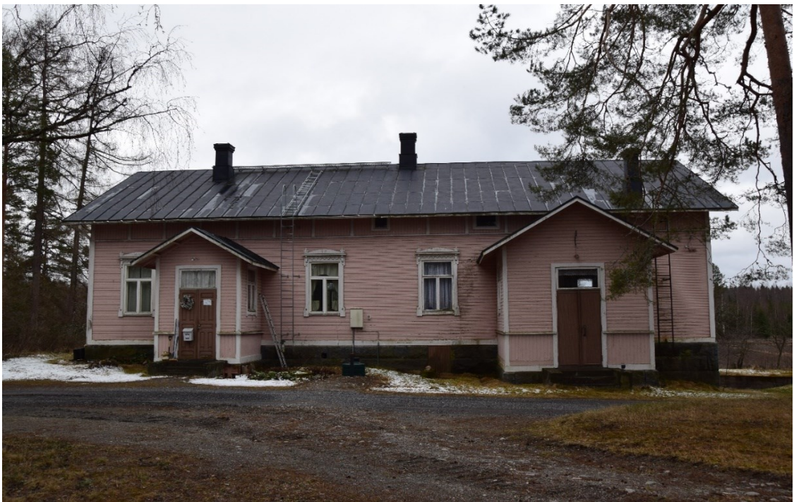
KUVA 6. Valokuva rakennuksen pohjoisesta julkisivusta
