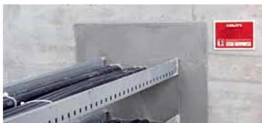
Kuva 3. Hiltin sementtipohjainen palokatkomassa asennettuna
