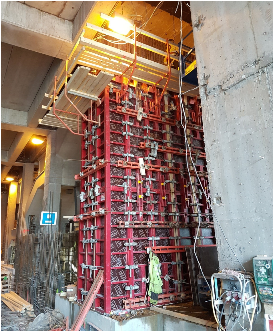
Kuva 10. Massiivipilarin muotti
