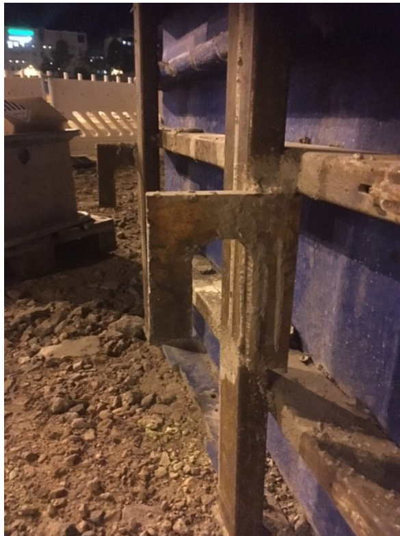
Kuva 9. Muottiin hitsattu erikoiskiinnike, josta kurottaja saa kunnollisen otteen.
