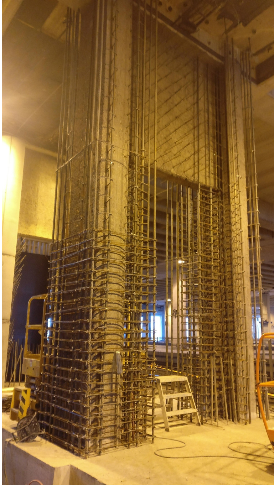
Kuva 6. Massiivipilari raudoitettuna.
