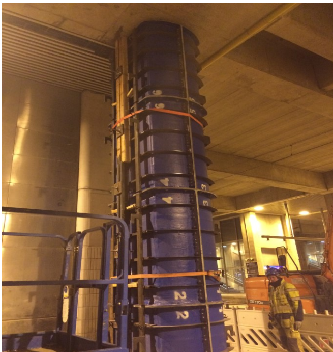
Kuva 7. Valmis muotti asennettuna.
