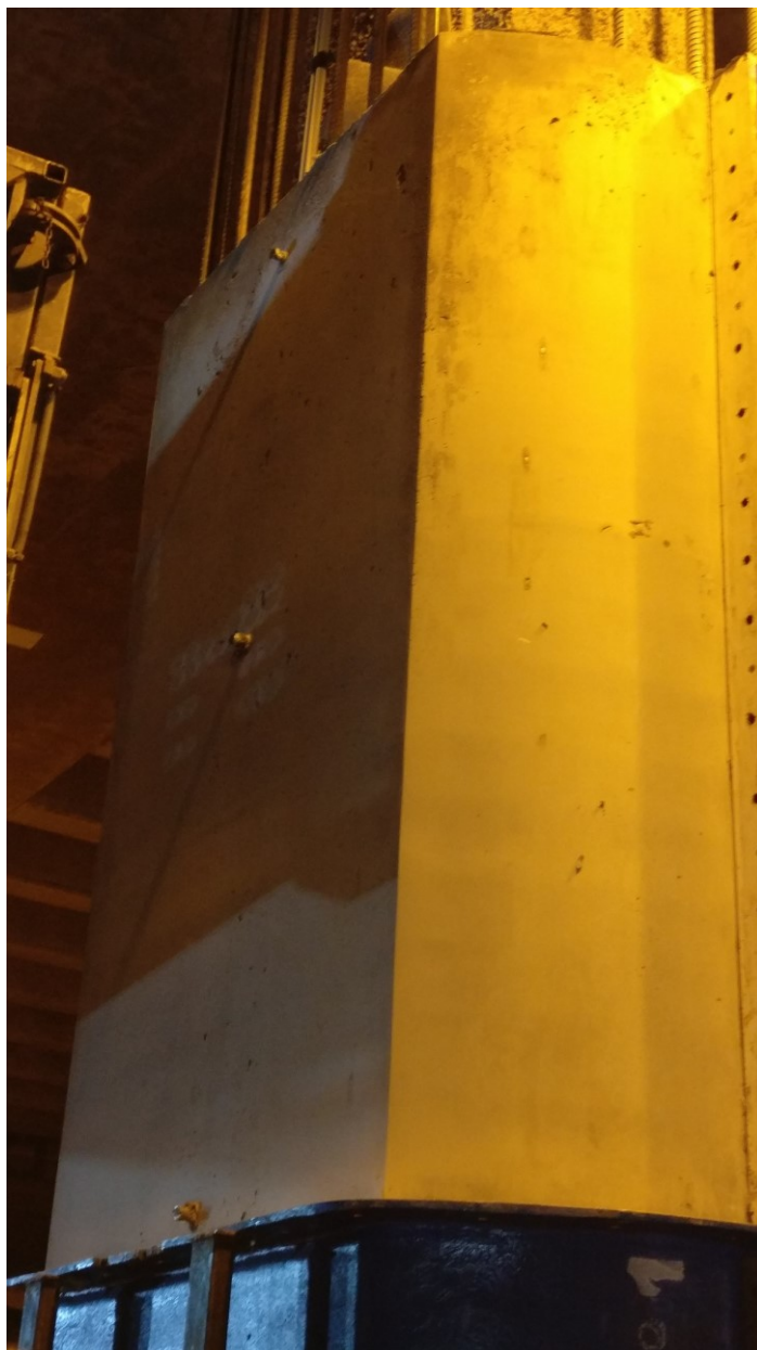
Kuva 13. Betonoitu pilari
