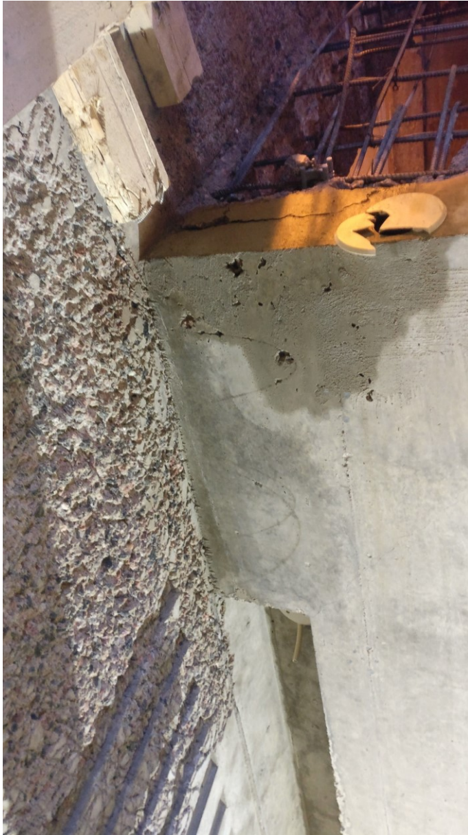
Kuva 3. Karhennettu betonipinta ja käsittelemätön betonipinta.
