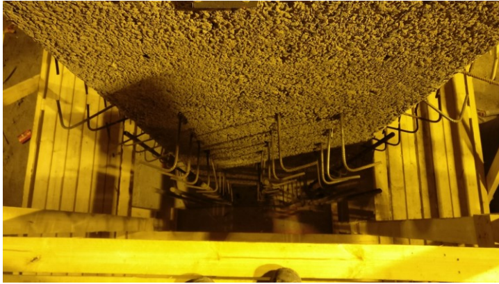
Kuva 4. Ankkuroitu pilari
