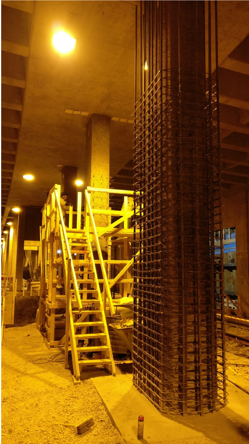
Kuva 5. Raudoitettu pilari ja puutavarasta tehty teline päivävuorolle raudoittamista varten.
