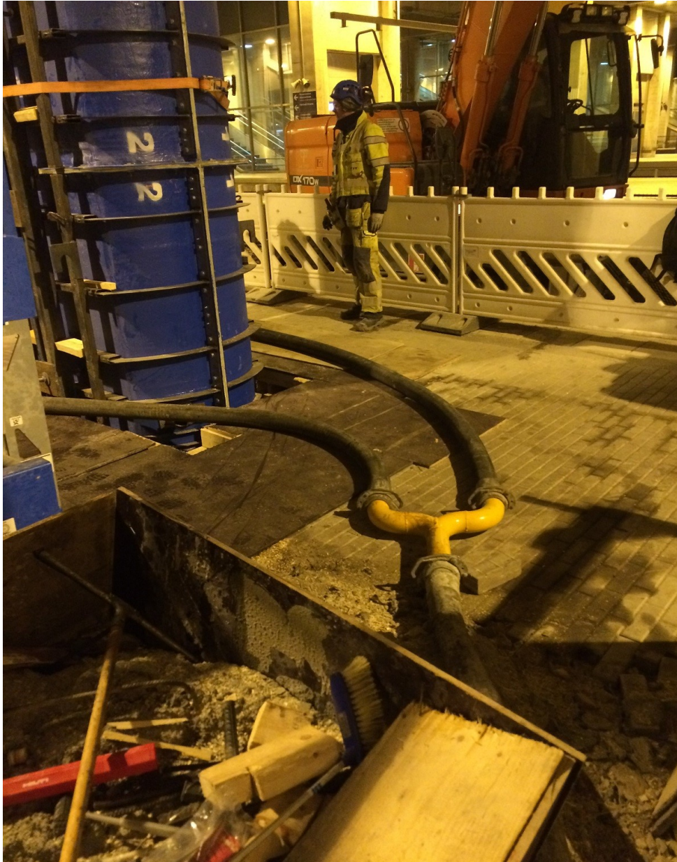
Kuva 11. Pilari valussa. Valuletkut liitettynä muotin alaosaan.
