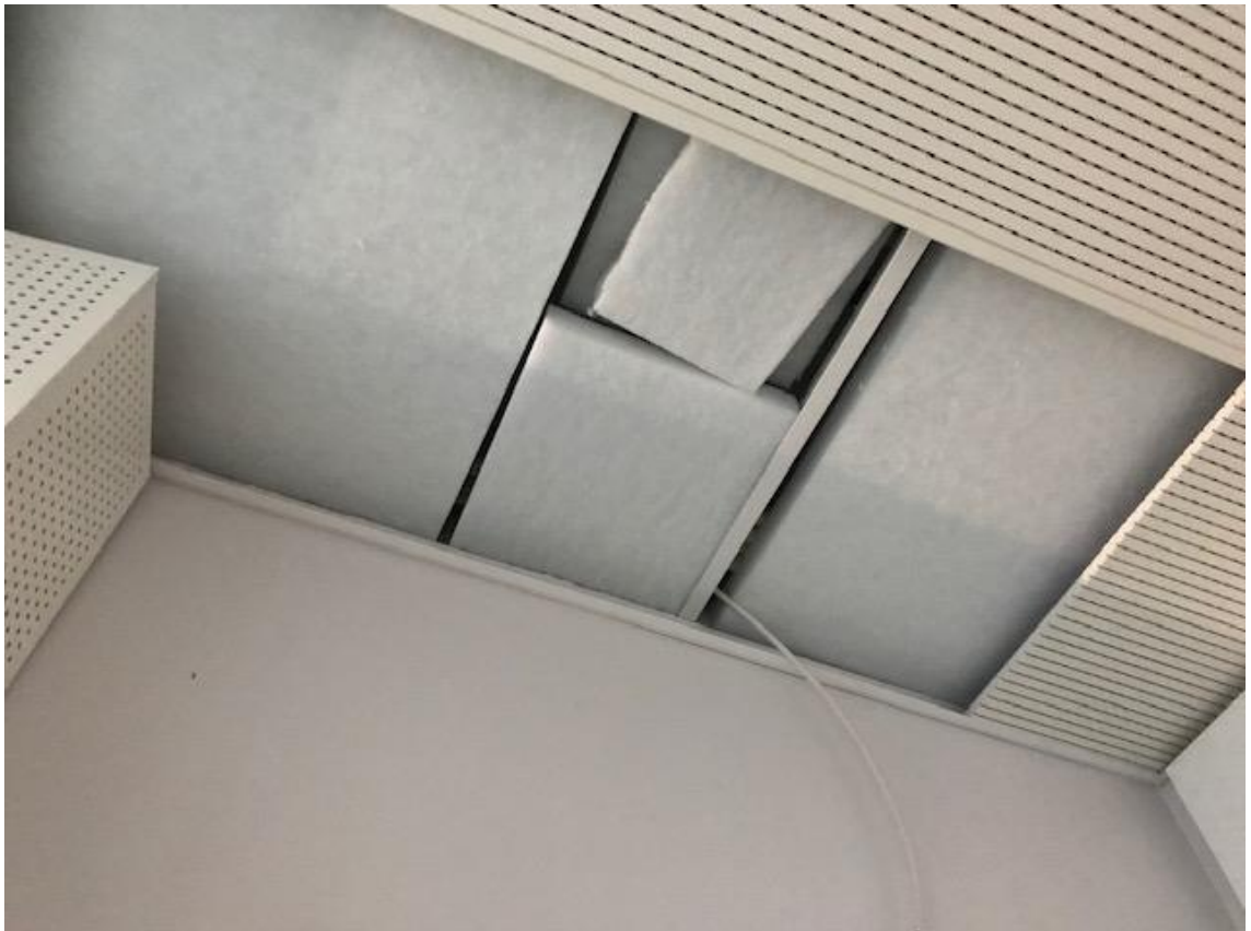
Kuva 12. Jousirankarakenteen ja alas lasketun katon välisen tilan eristettä.
