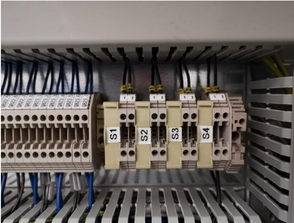
Kuva 26. Servo-ohjainkaapin riviliitinkytkenät turvareleille.
