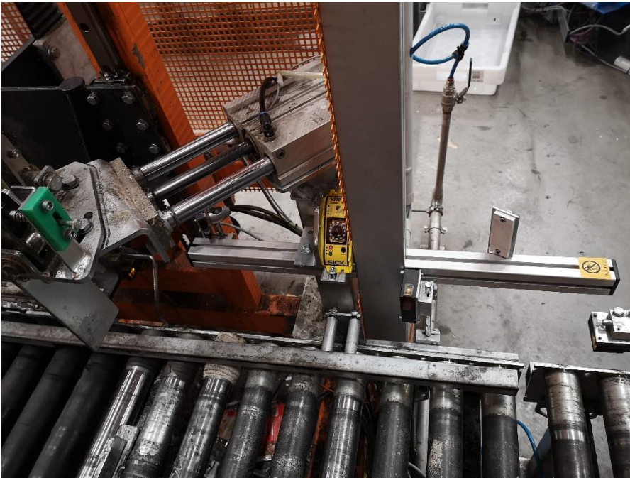
Kuva 17. Ulostuloportin kamera ja mykistyskennot rautoineen asennettuna
