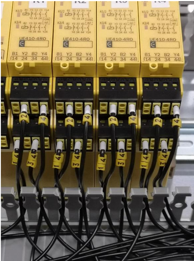
Kuva 9. Relemoduulien johdotusta
