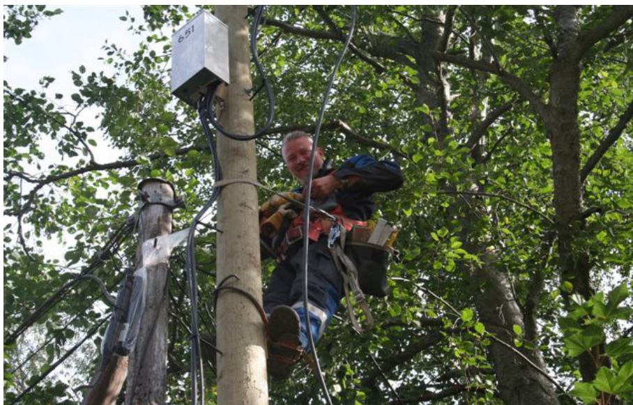
Kuva 5. Suuri osa puhelinjasta kulkee ilmassa
