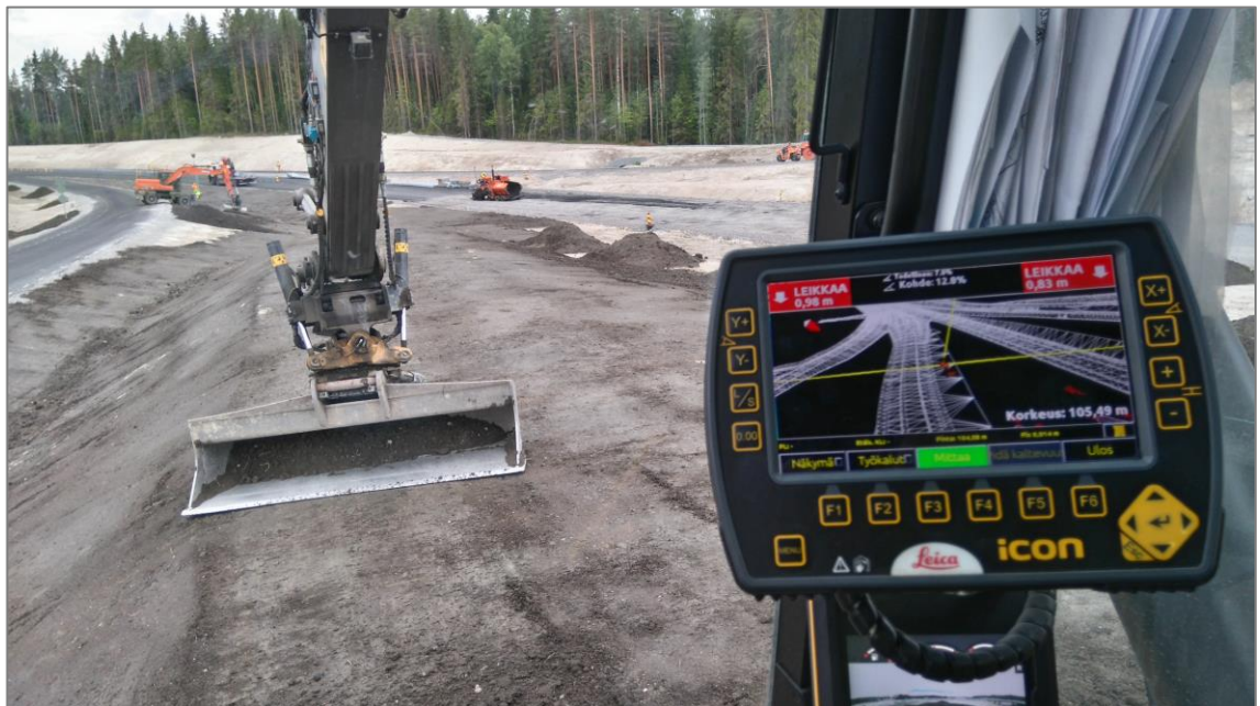
Kuva 10. Koneohjauksen kuljettajan näkymä kaivinkoneen ohjaamosta [Lönnberg 2018].
