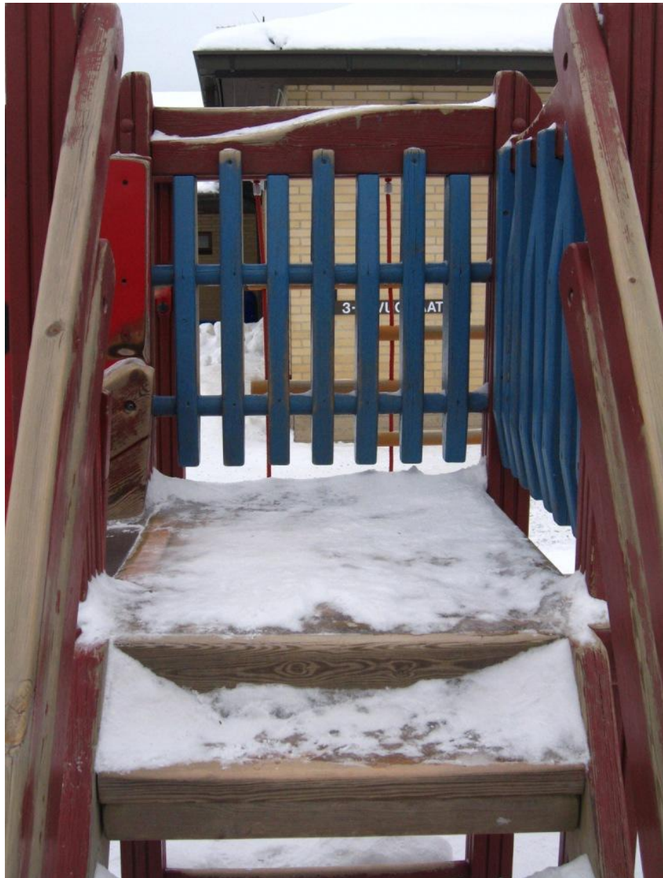
KUVA 4 Portaisiin ja tasoihin pakkaantunut lumi ja jää tekevät leikkivälineistä vaarallisen liukkaan. Kuva: Pilvi Pouttu, 25.2.2011 Härmälän päiväkot, Tampere.
