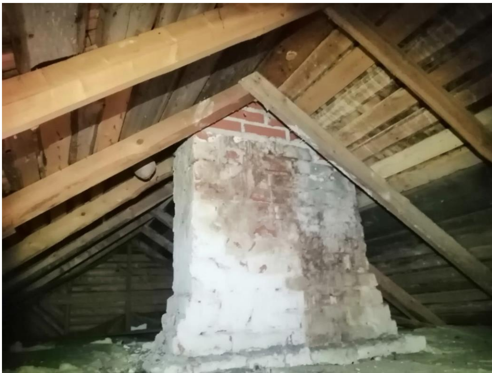
Kuva 10. Rakenteiden kunto välikatossa.
