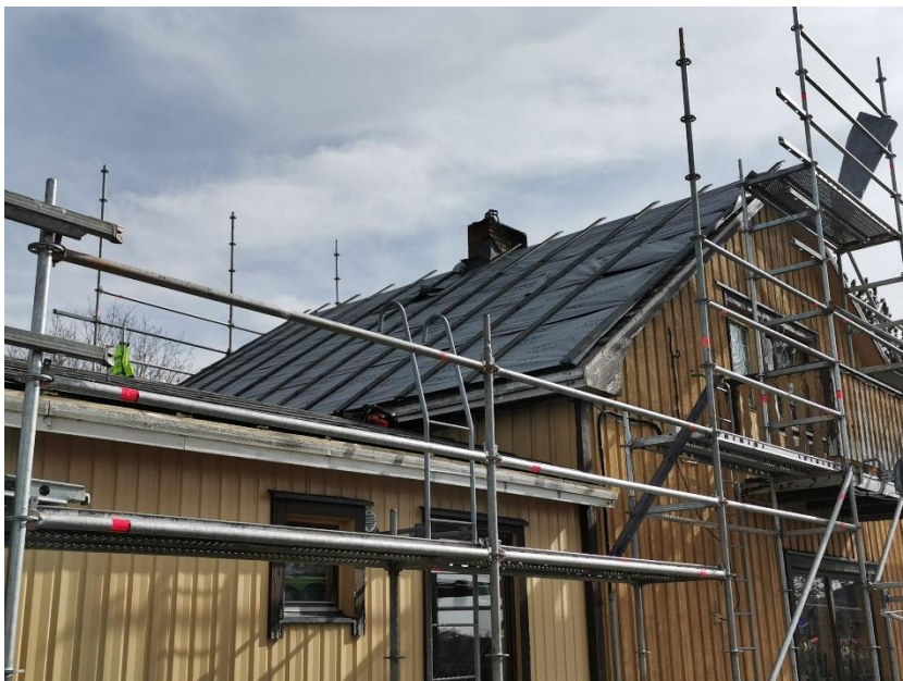
Kuva 23. Aluskate ja pystyruoteet asennettuna.
