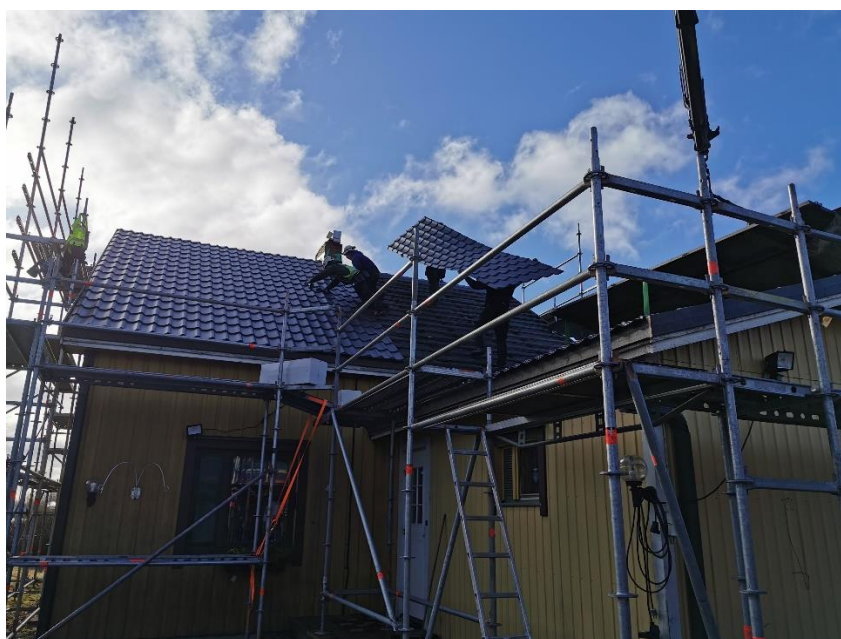
Kuva 27. Peltikatteen asennus.
