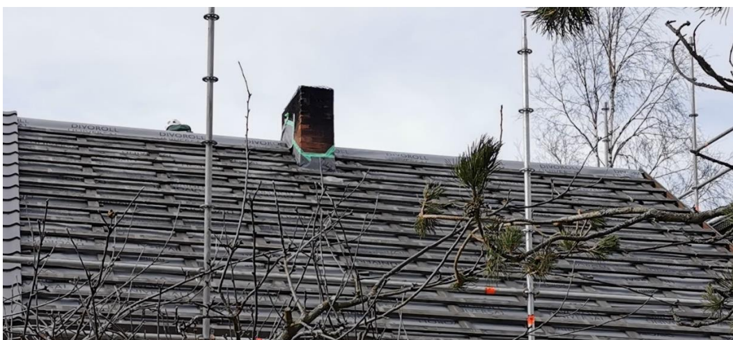
Kuva 26. Harjalle asennettu aluskate.
