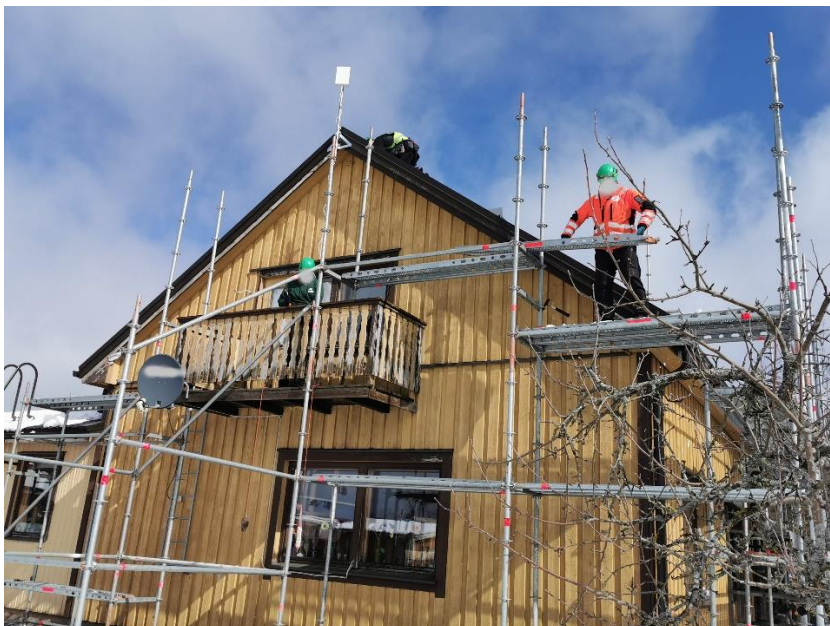
Kuva 31. Telineiden purkaminen.
