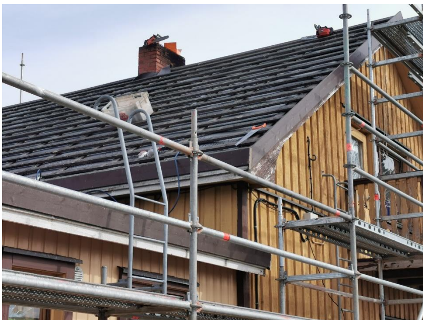
Kuva 25. Räjstäisiin asennetut uudet otsalaudat.
