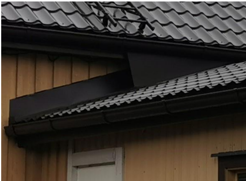
Kuva 29. Lisäsiiven liitoskohta.
