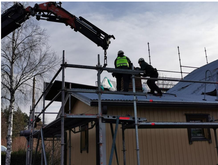
Kuva 15. Lisäsiiven piipun purku.
