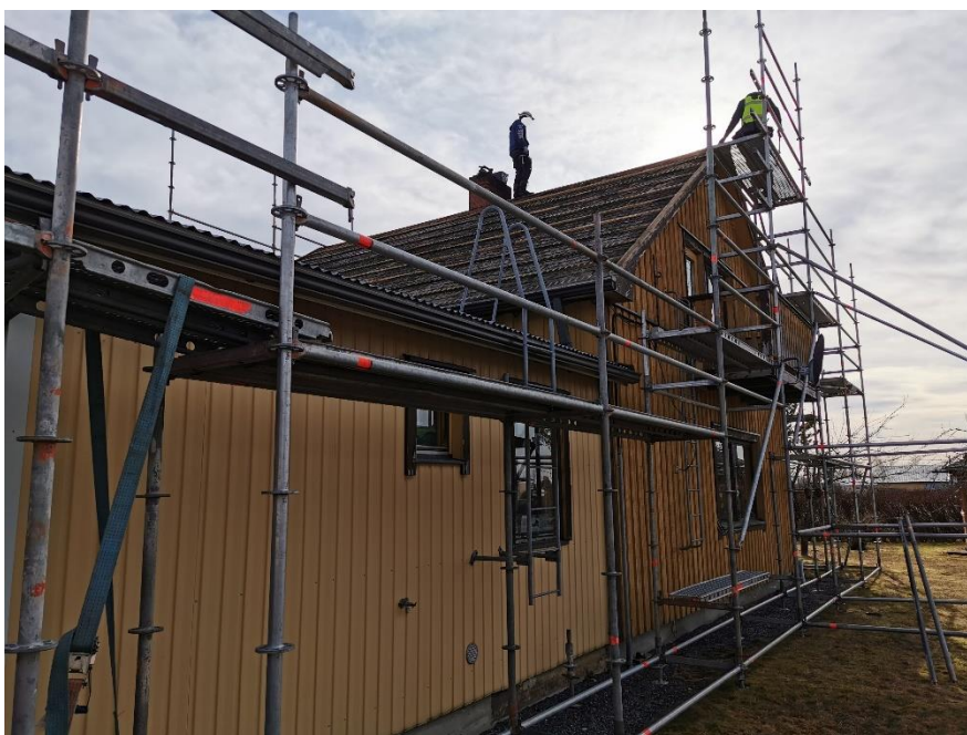
Kuva 16. Peltikatteen purku.
