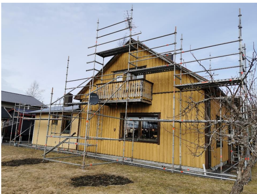
Kuva 13. Telineet valmiina takapihalla.
