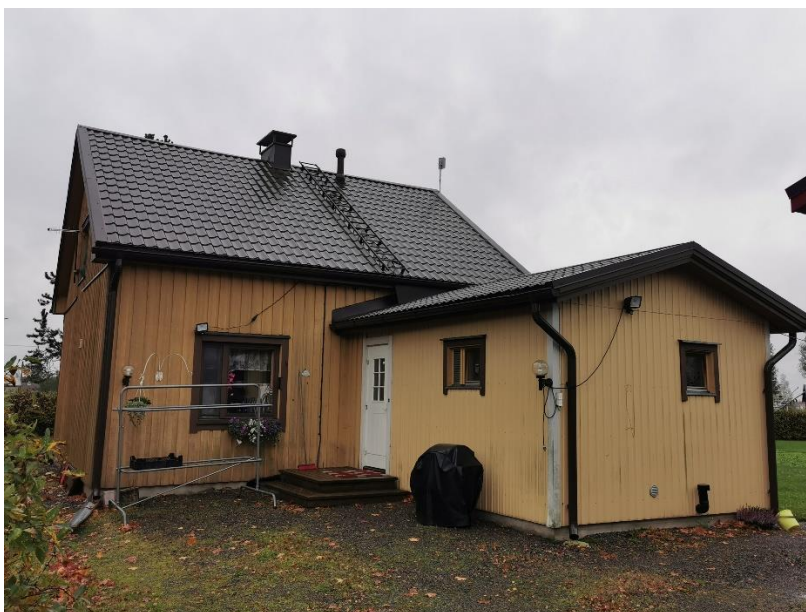
Kuva 32. Valmis katto rakennukselle.
