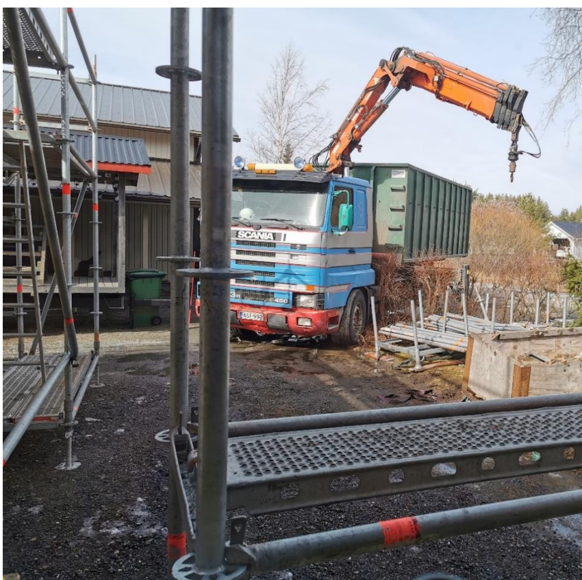
Kuva 11. Telineiden ja tarvikkeiden toimittaminen työmaalle.
