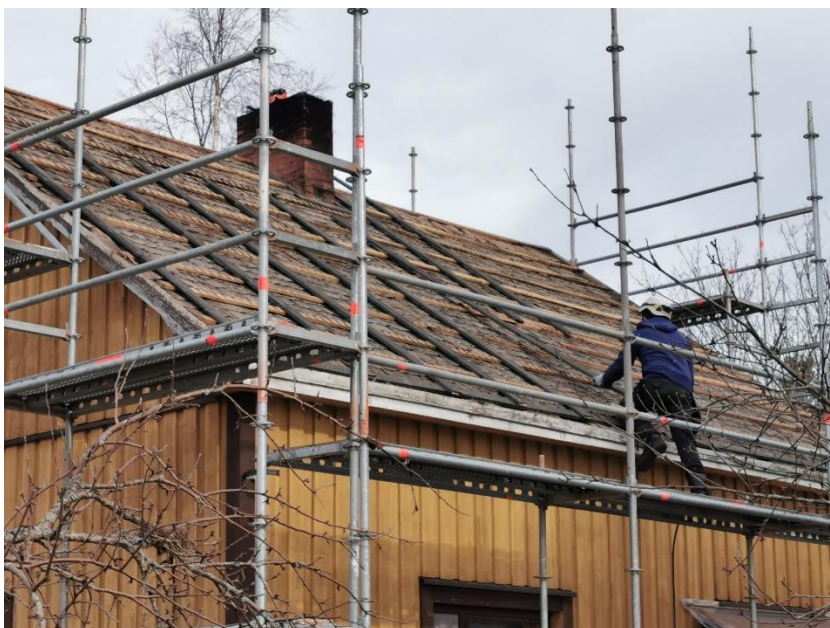
Kuva 21. Alusrakenteen asentaminen.
