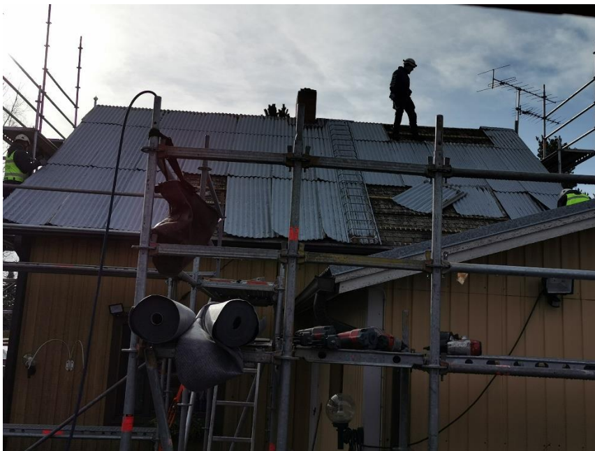
Kuva 14. Vanhan peltikatteen purku.
