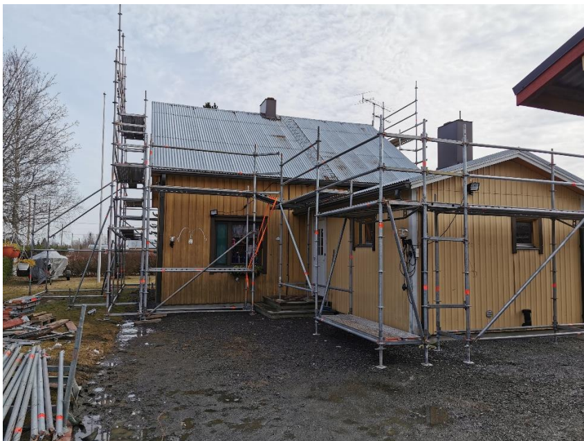
Kuva 12. Telineet valmiina etupihalla.
