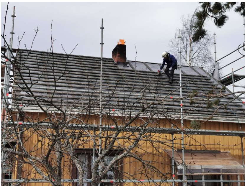
Kuva 24. Vaakaruoteiden asennus.
