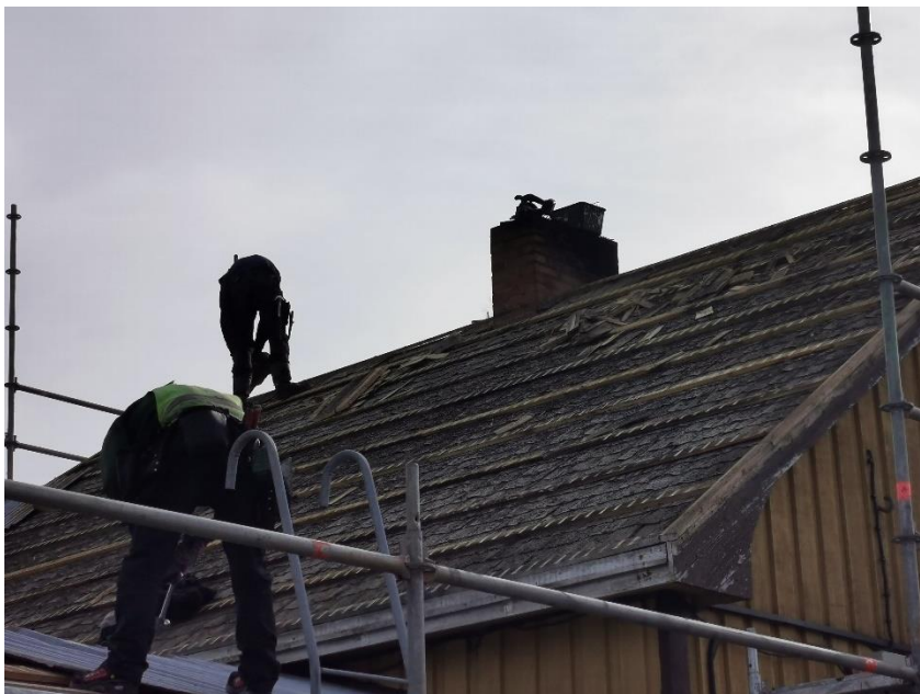
Kuva 20. Tuuletus reikien teko välikattoon.
