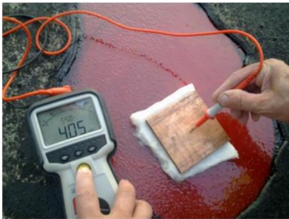
KUVA 10. Vastuksen mittaus. (betoniyhdistys.fi, 11.1.2018).
