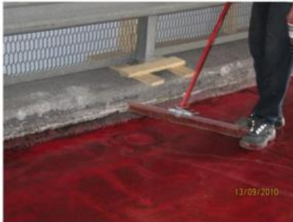
KUVA 11. Epoksikannen tiiveyden mittausta kipinäharavalla. (betoniyhdistys.fi 11.1.2018).
