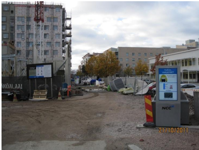
Kuva 23. Ulkonäytön sijainti työmaalla HOAS Jätkäsaari
