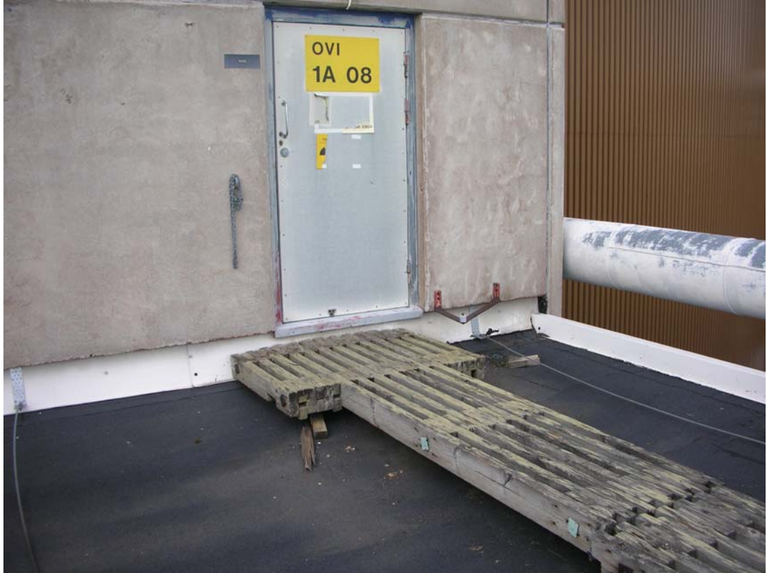
Kuva 11. Kulkusilta valvotun alueen rajaovelta, nivelosasta
