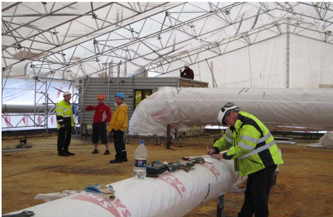
Kuva 15. 1A:n katolla sijaitsevat IV-putkistot ja -venttiilihuone.
