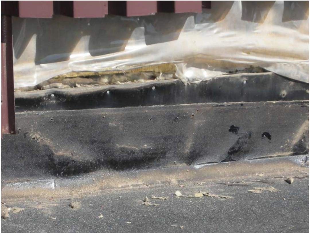
Kuva 7. Seinällennosto reaktorirakennuksen ja katetun säiliöalueen liittymästä
