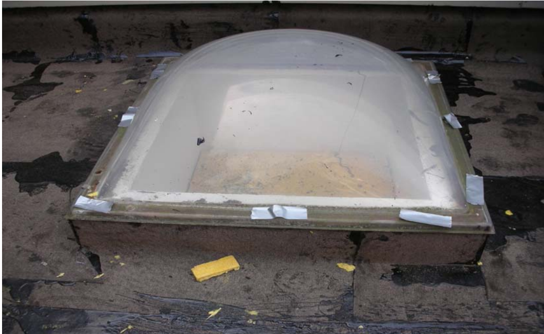
Kuva 2. Laboratoriorakennuksen vanhat kupoli-ikkunat ennen poistamista
