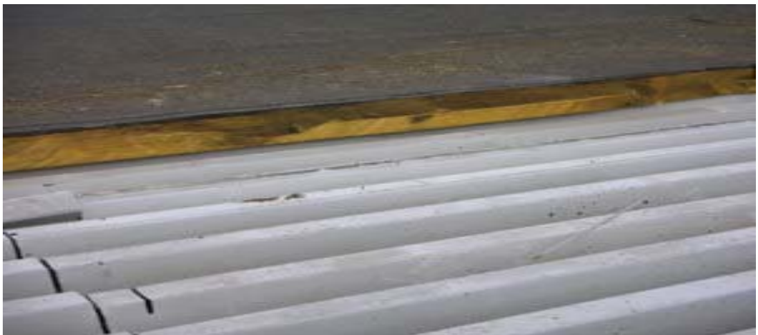
Kuva 1. Turpiinisalin yläpohjan rakenne
