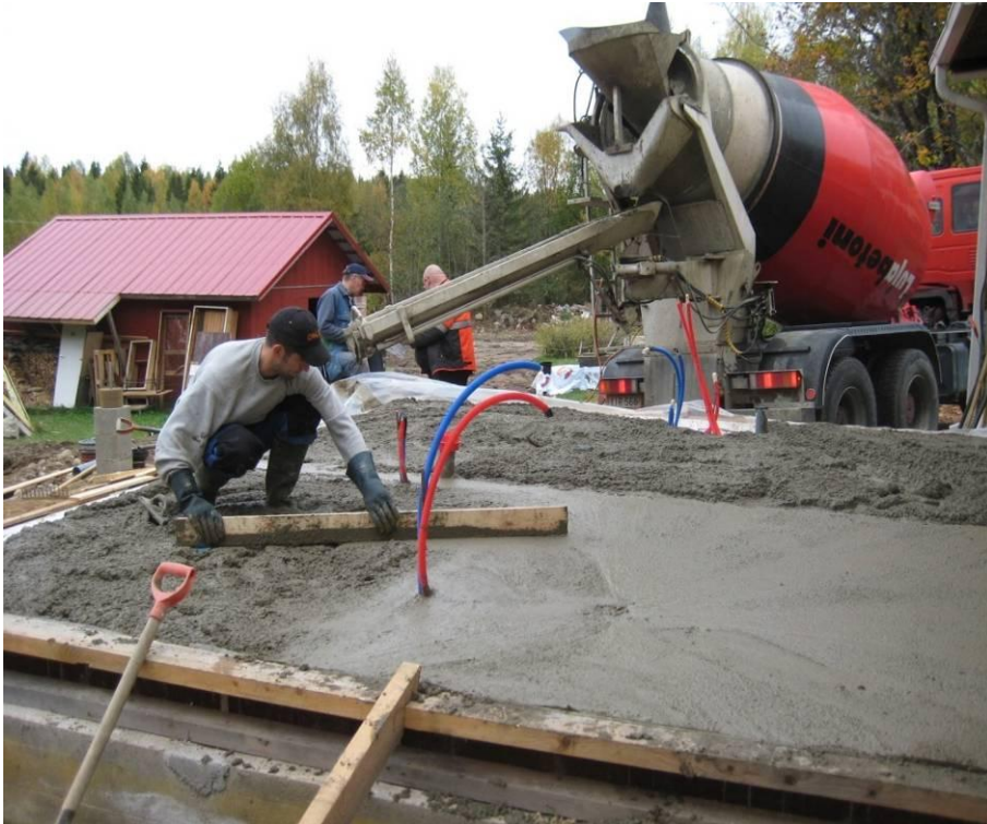
KUVA 3. Maanvaraisen lattian valu. Kuva: Helena Junttanen 2010.
