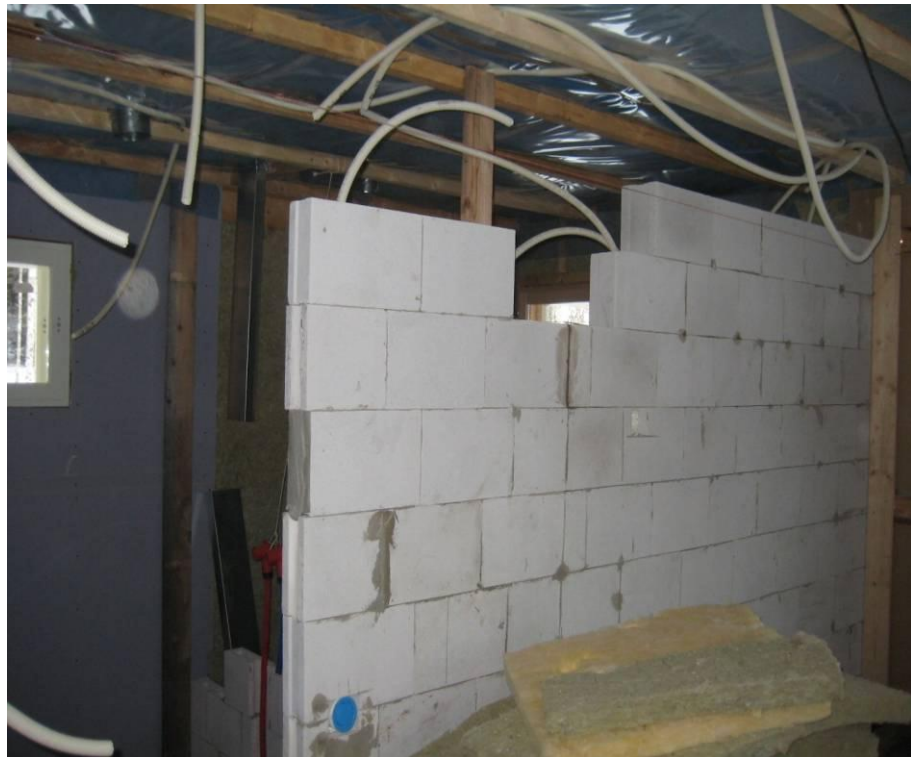
KUVA 5. Väliseinämuurausta. Kuva: Simo Ahtonen 2010.
