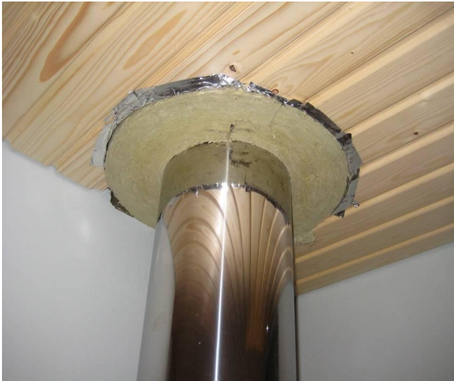
KUVA 6. Teräspiipun läpivienti saunan sisäkatoissa. Kuva: Simo Ahtonen 2010.
