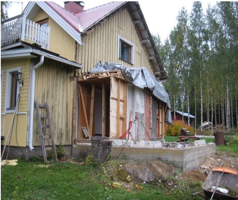
KUVA 2. Purkutyömaan tilanne 11.9.2010. Kuva: Simo Ahtonen 2010.
