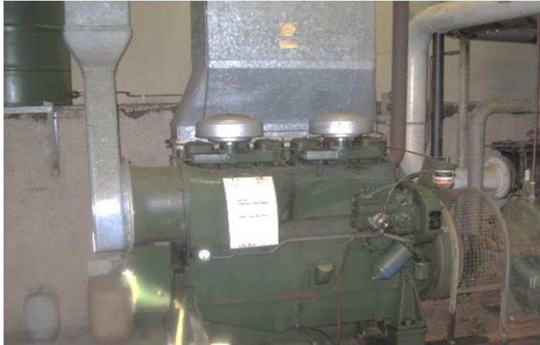
KUVA 1. Sprinklerin varavoimageneraattori
