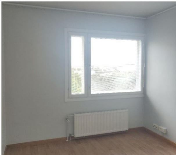
Kuva 16. Asuinhuoneiston ulkoseinä (Krogus 2020)
