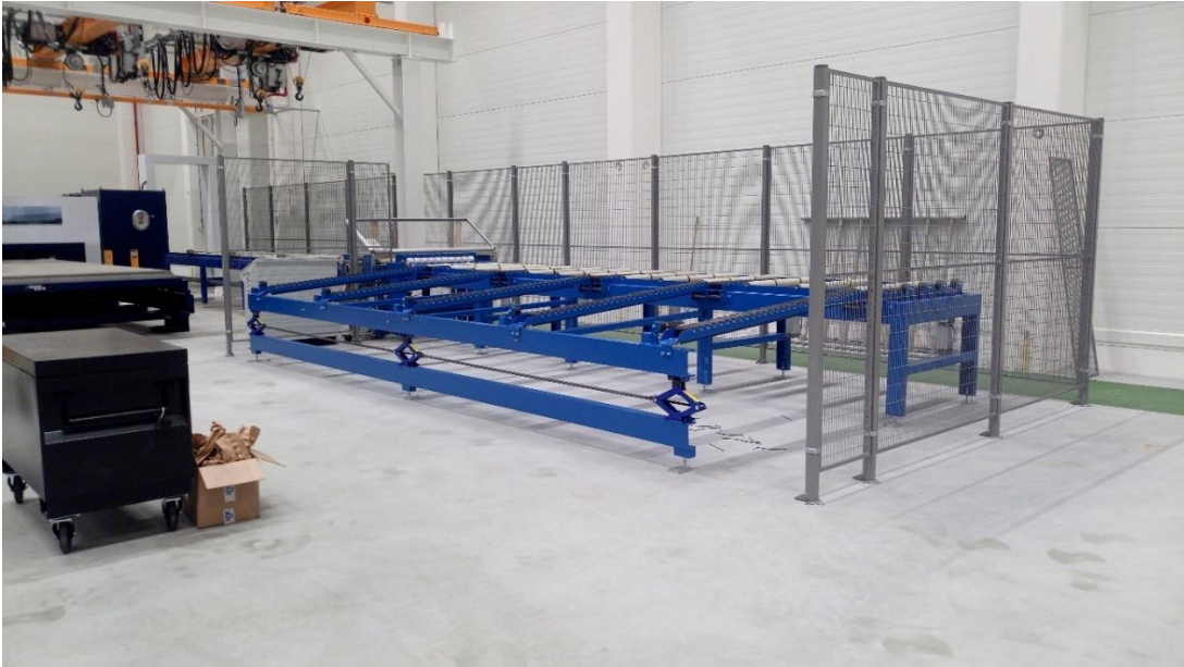
Kuva 18. Tyssäin linja asennettuna paikalleen ja suoja-aidoitettuna (Kananen 2019)
