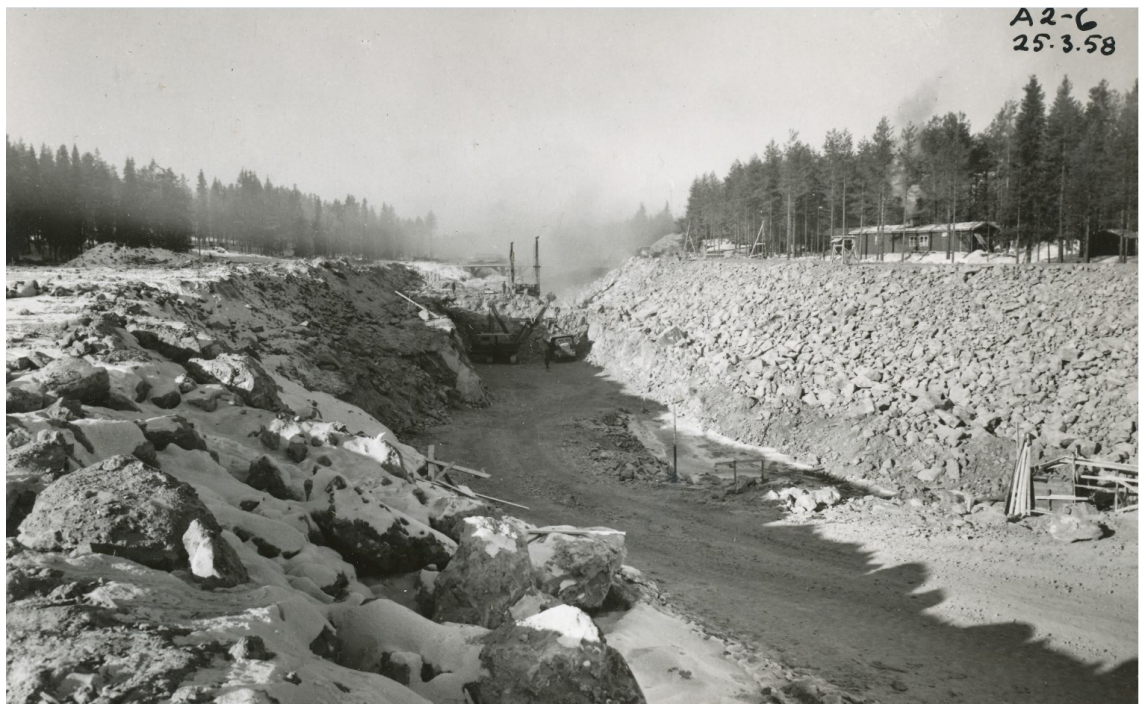
Kuva 6 Emäjoen kaivaminen Kuva: Fortum Power and Heat Oy arkisto
