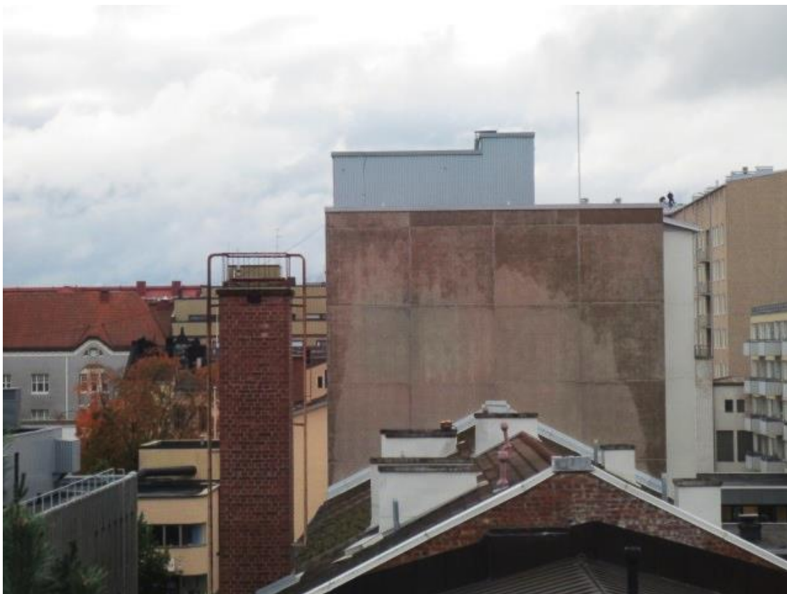
KUVA 2. Viistosateen vaikutus rakennuksen yläosassa räystäättömässä rakennuksessa. (Varjonen 2013)
