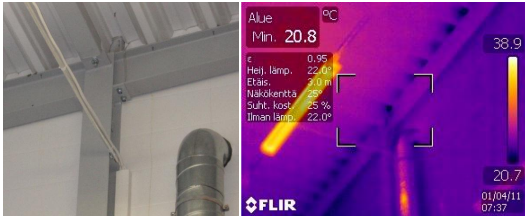
KUVA 9. Katon läpäisevä terästolppa palkin päässä
