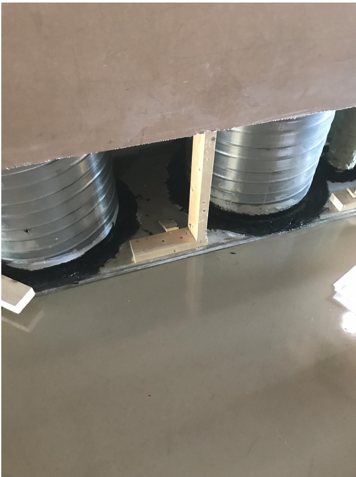
KUVA 4. Kotelon sisällä olevien ilmastointiputkien läpiviennit tiivistettiin tumman sinisellä Aerosanalla. (Oma arkisto)
