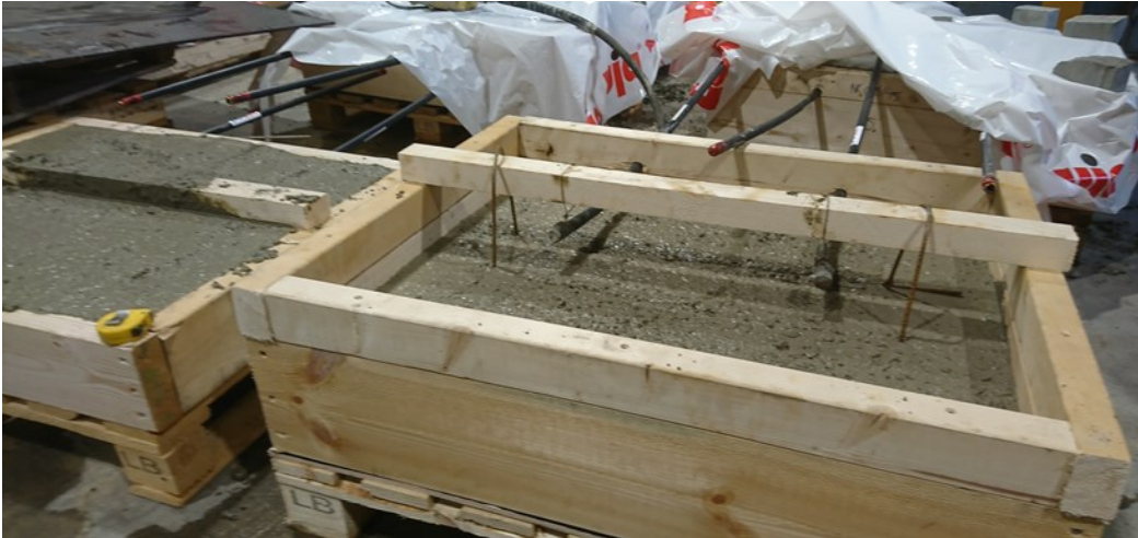
KUVA 4. Betonin valaminen muotteihin
