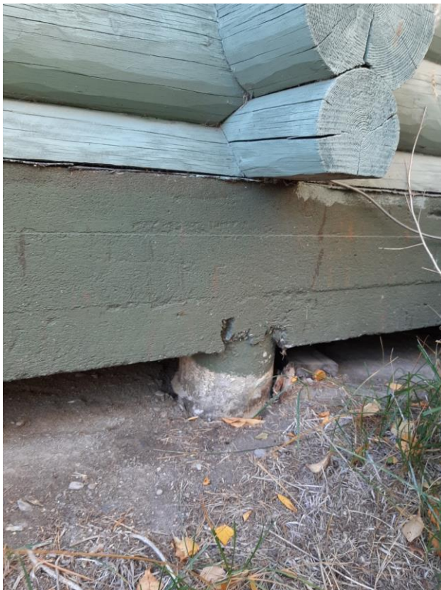
Kuva 2. Sokkelibetonipalkki ja pilari
