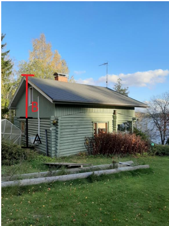
Kuva 1. Kuva kohteen takaseinästä. A kirjaimella merkitty hahmotukseksi vanha hirsiseinä ja B kirjaimella uudempi puuseinärakenne
