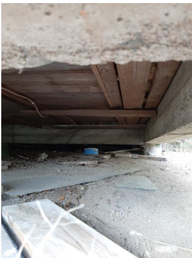
Kuva 3. Vanhaa alapohjarakennetta kuvattuna sokkelibetonipalkin alapuolelta.
