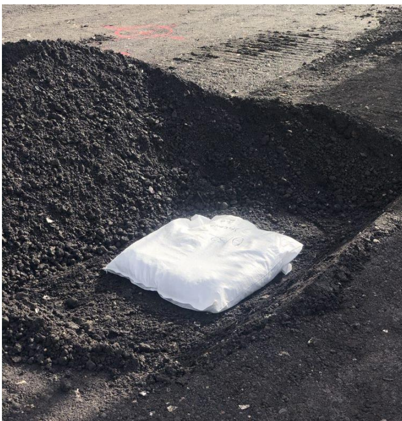
KUVA 8. Hienonemissäkin asennus jakavaan kerrokseen.
