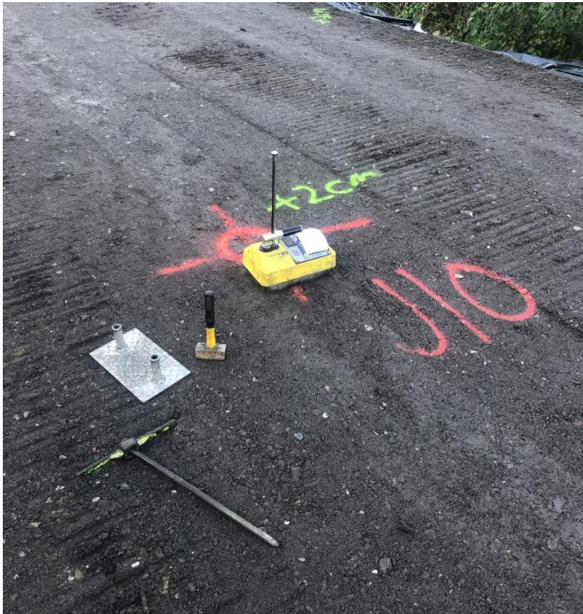
KUVA 9. Troxler-säteilymittaus jakavasta kerroksesta.
