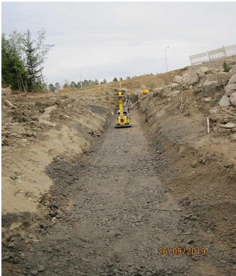
Kuva 1. Luiskattu, matala kaivanto (Huikari 2019)
