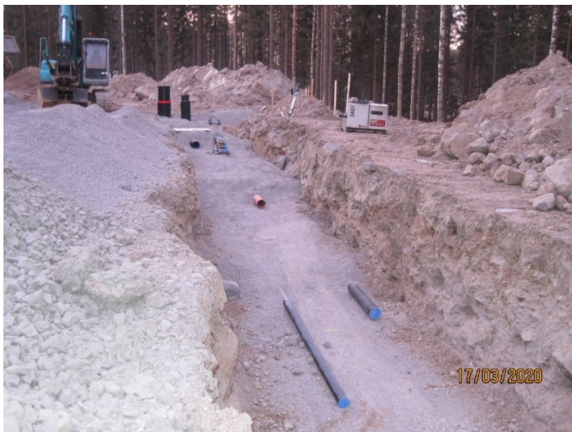
Kuva 5. Putkien arina ja asennusalusta kolmessa eri korossa (Huikari 2019)
