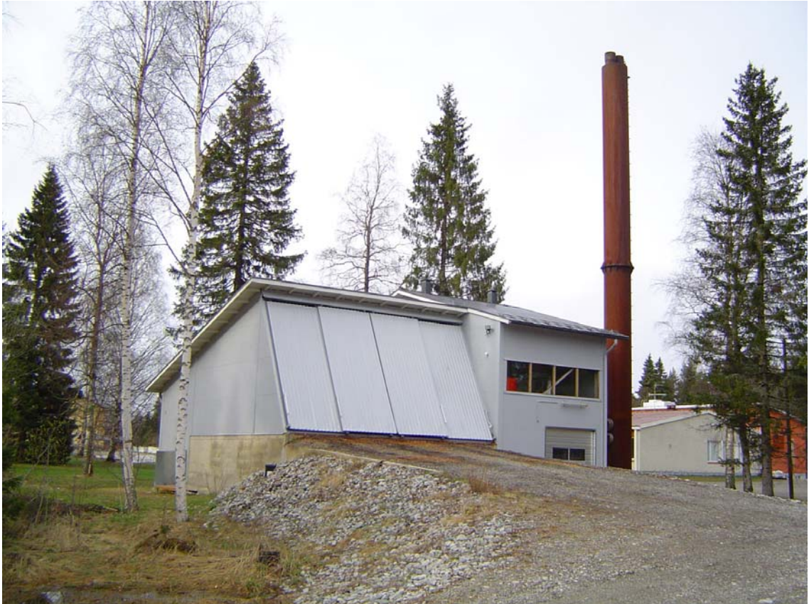
Kuva 3. Enon yläkylän lämpölaite. (Kuva: Urpo Hassinen.)
