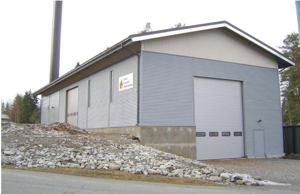
Kuva 2. Enon alakylän lämpölaitos. (Kuva: Urpo Hassinen.)
