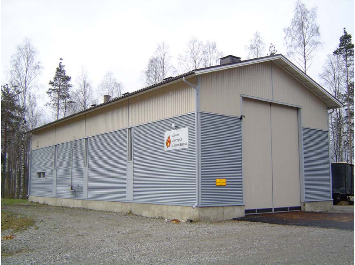
Kuva 4. Uimaharjun lämpölaitos. (Kuva: Urpo Hassinen.)
