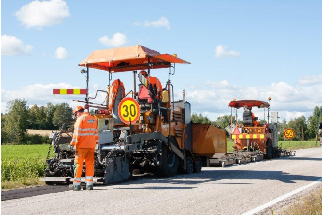
KUVA 1. Peab Asphalt Uraremontyömaa Kestilä 2020
