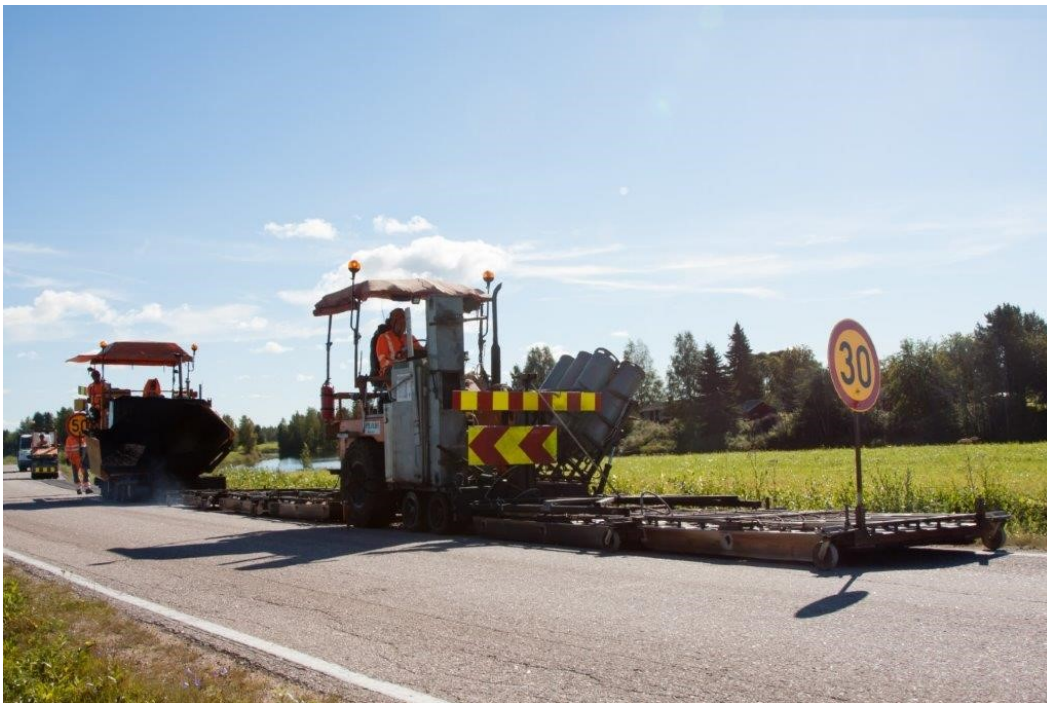
KUVA 2. Peab Asphalt Uraremontyömaa Kestilä 2020
