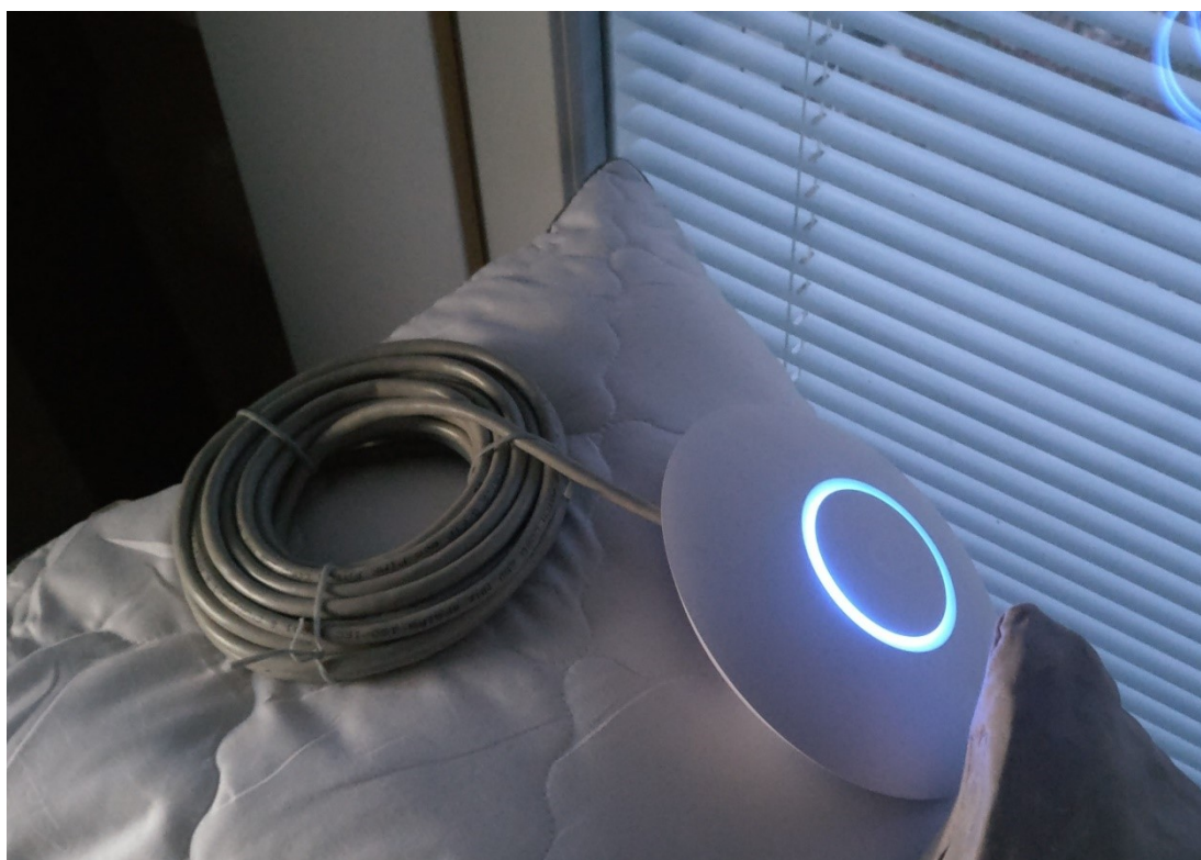
Kuva 25 Alamökin/saunan tukiaseman asennusvaihe
