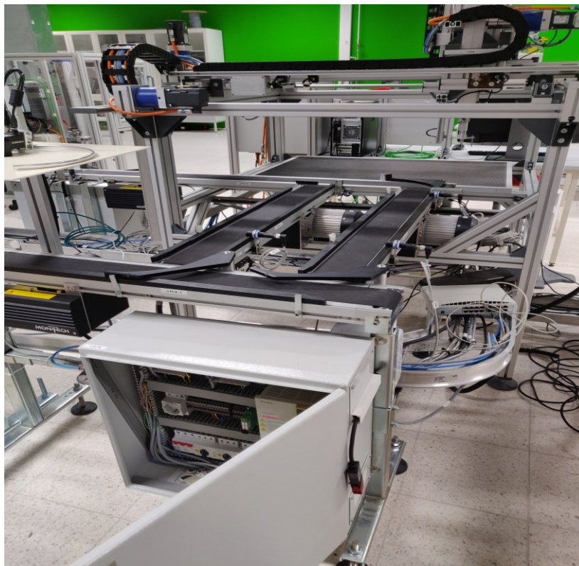
Kuva 4. Varastokuljettimet, vastaanottokuljetin (takana) ja portaalirobotti.
