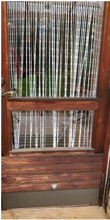
Kuva 1. Käytössä oleva pääovi (terassin ovi).
