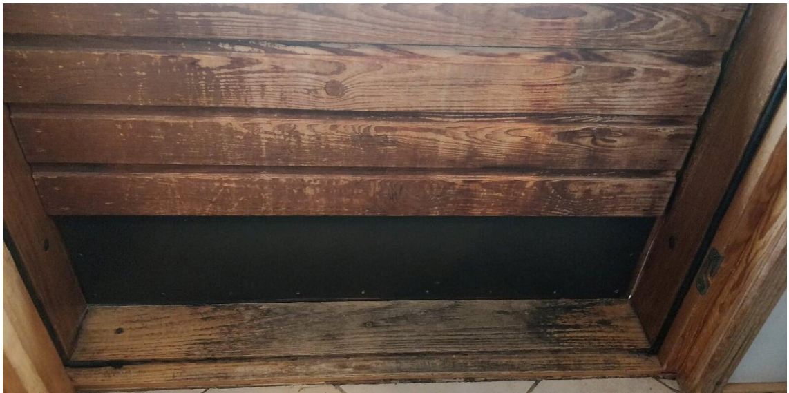
Kuva 2. Käytössä oleva pääovi (terassinovi) sisäpuolelta.
