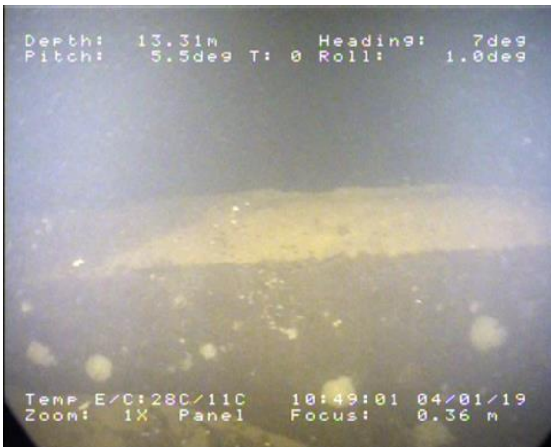
Kuva 11. Betoninen tukirakenne. (Yrityksen kuva-arkisto 2019)
