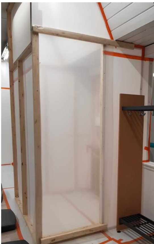
Kuva 2. Puusta ja kennomuovista valmistettu osastointi.
