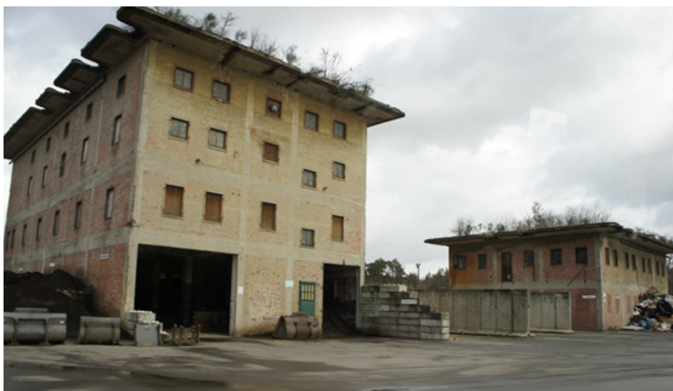
Kuva 1 Entisiä ammusvarastoja, jotka on otettu kiertotalousosuuskunnan käyttöön Saksassa (Kuva: Kari Laasasenaho)
