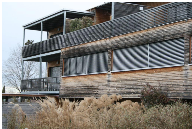
Kuva 10. Käsittelemätön ulkoverhoilu on saanut iän tuomaa väritystä Hermann Kaufmannin suunnittelemassa talossa (Bere:Architects 2011)
