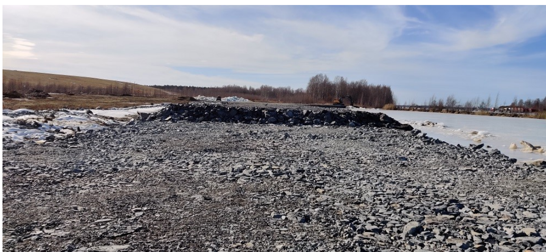
KUVA 12. Penkereen rakentaminen Cederbergin aukio (Matilainen Tiina)
