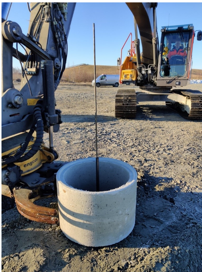
KUVA 17. Painumamittauspisteen asennus (Matilainen Tiina)
