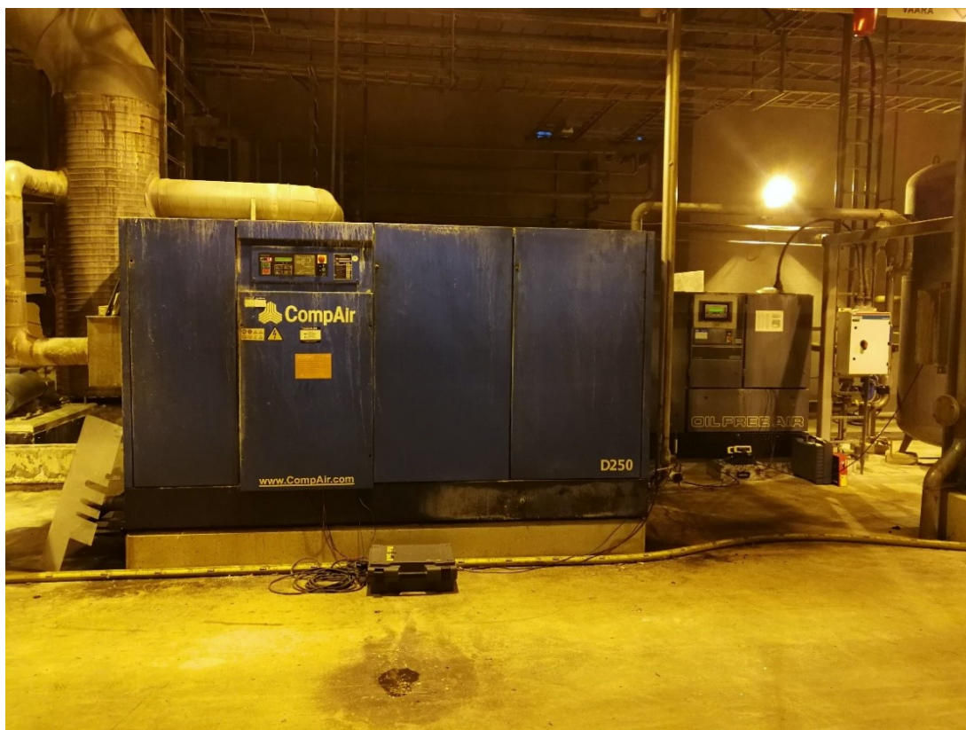
Kuva 4. Vanhat kompressorit massatehtaan alakerrassa
