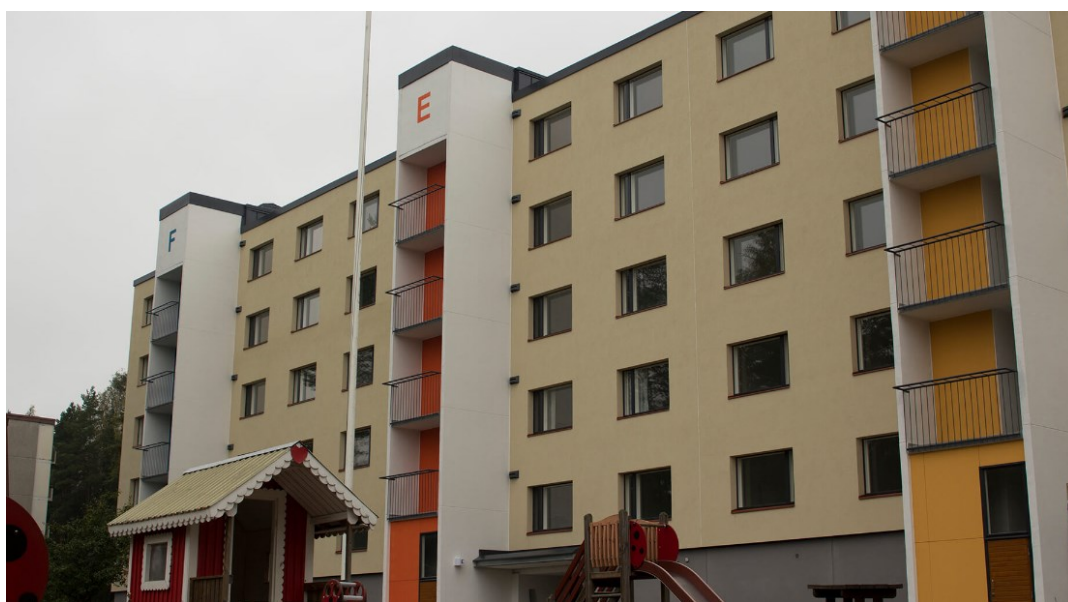
Kuva 4. SerpoVent levyrappauksella toteutettu julkisivun korjaus 1970-luvulla ra- kennettuihin asuinkerrostaloihin. (Weber www-sivut 2020c.)
