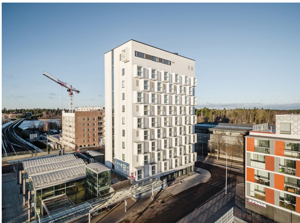
Kuva 3. Asunto Oy Helsingin Viuhka sai palkinnon vuoden 2016 betonirakenteena. Julkisivut toteutettu betonisandwich-elementeillä. (Betoni www-sivut 2020.)
