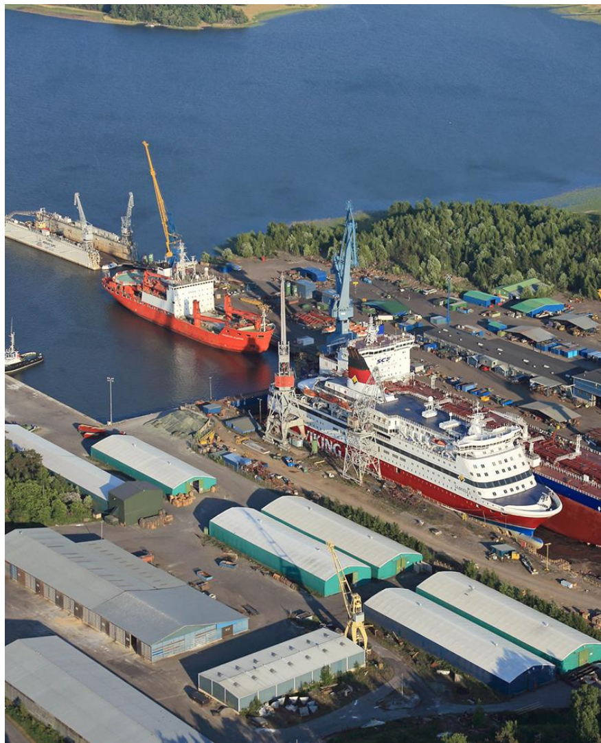
Kuva 2. Telakka ennen modernisointia (Turun korjaustelakka, 2020)
