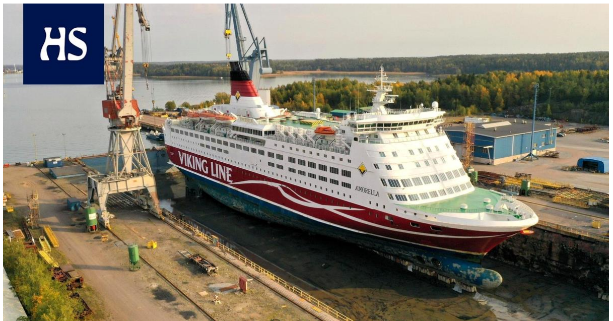
Kuva 8. Nosturi valmiina (HS, 2020)
