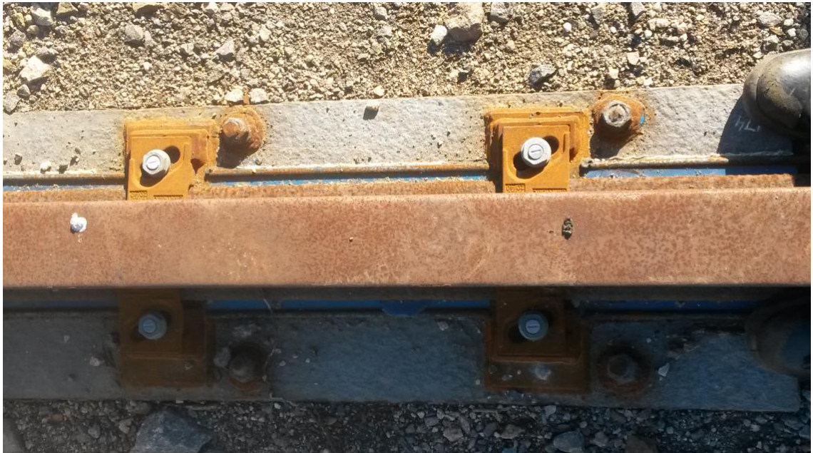
Kuva 6. Raide kiinnikkeineen ja epoksivaluhartsin kanssa
