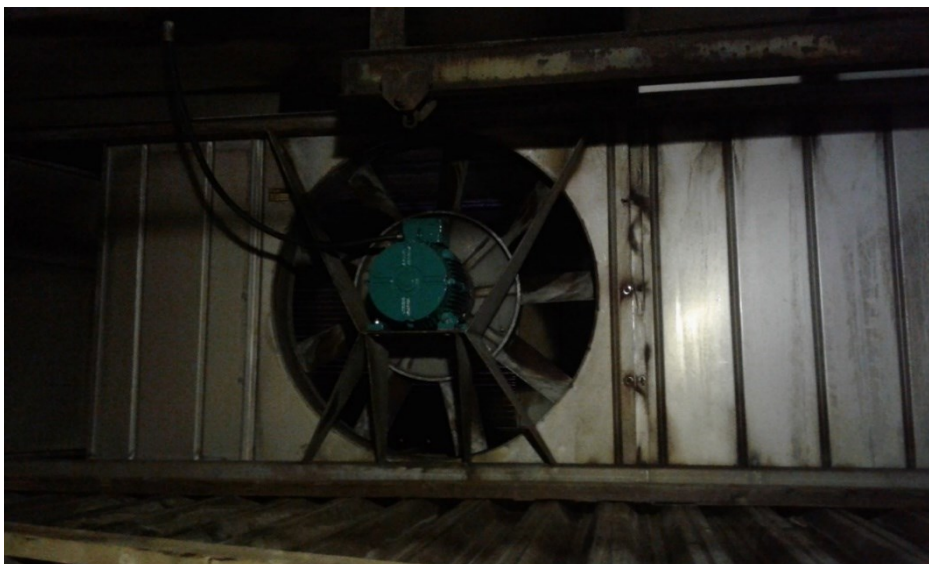
Kuva 15. Kamarikuivaamon kiertoilmapuhallin
