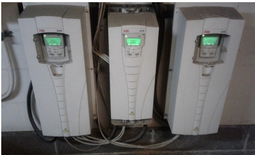
Kuva 19. Ykköskamarin taajuusmuuttajat
