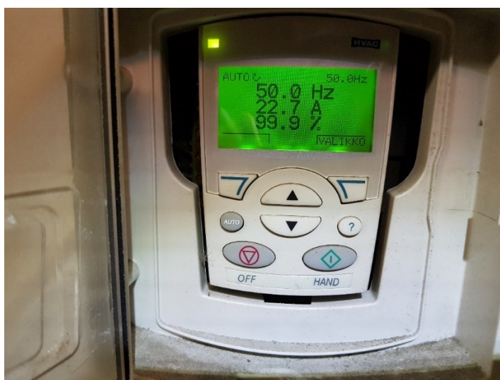
Kuva 24. Moottorin ottama virta 50 Hz:n taajuudella.
