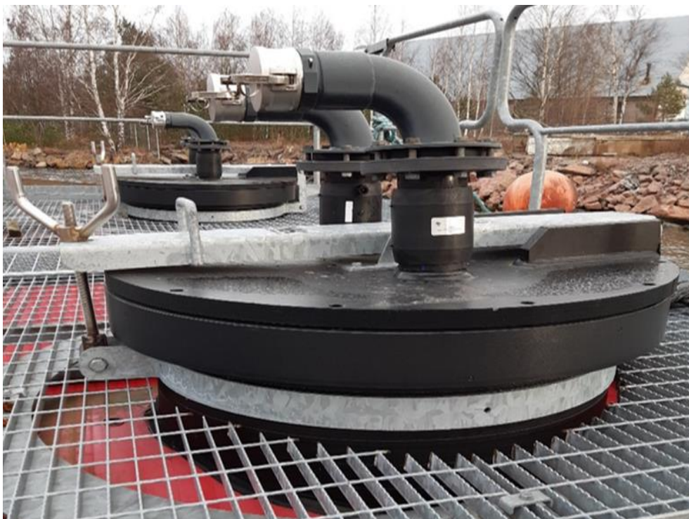
Kuvio 16: Säiliön täyttö ja tyhjennysliittimet (Rajavartiolaitos 2020).
