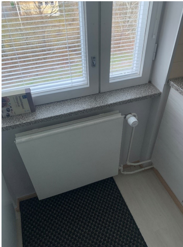
Kuva 12. As. Oy Mutkaheikkilän huoneistojen keittiön radiaattoreiden kytkentäratkaisu (Taneli Juhola 2020)
