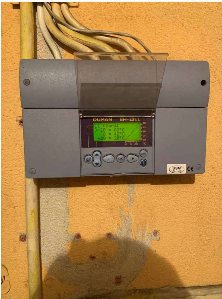
Kuva 10. As. Oy Mutkaheikkilän Ouman EH-201/L digitaalinen lämmönsäädin (Taneli Juhola 2020)
