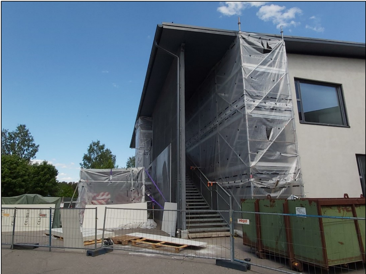
Kuva 5. Sääsuoja rakennustelineiden ympärillä julkisivukorjauskohteessa.
