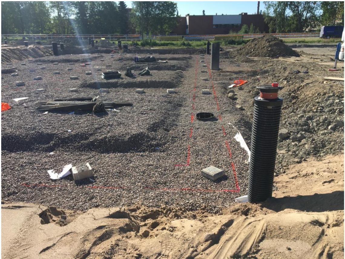
Kuva 2: Paalutettava suurkohde ennen perustustöitä.
