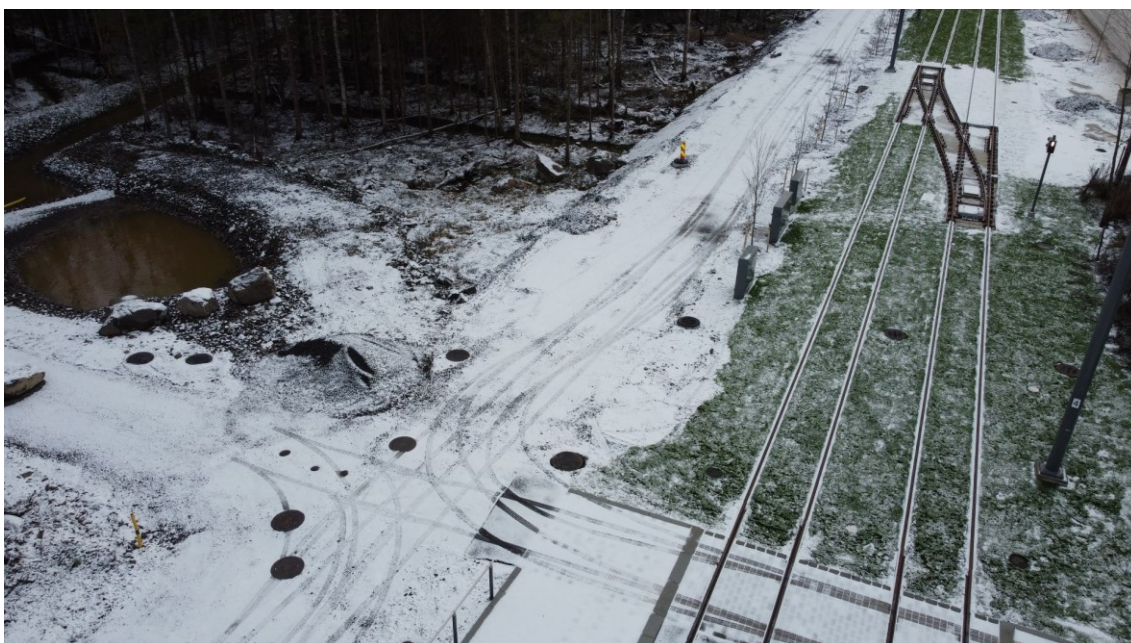
Kuva 6. Makkarajärven radan vieressä sijaitseva sadevesiallas
