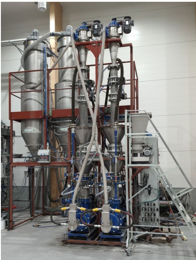
Kuva 6. Micropulvan toimittama FP3, 2-faasitekologiaan perustuva jauhinlineiteisto, BioSampo-tutkimuskeskuksessa. (Kuva Tomi Höök.)
